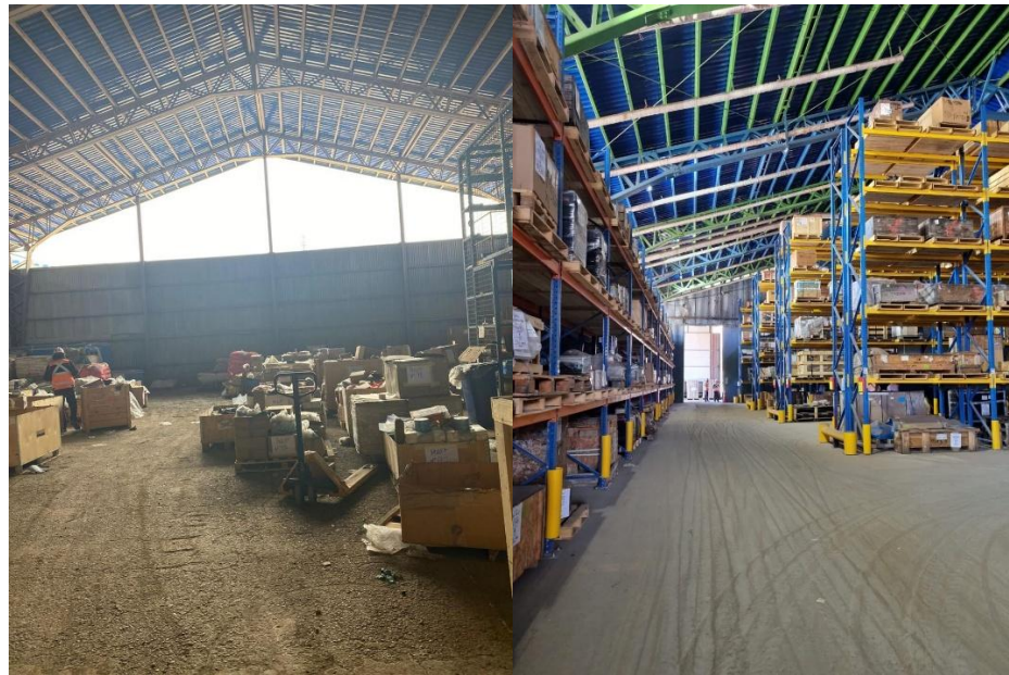
Figura N° 22. Bodega Patio Colón – Situación Inicial y Situación Posterior
