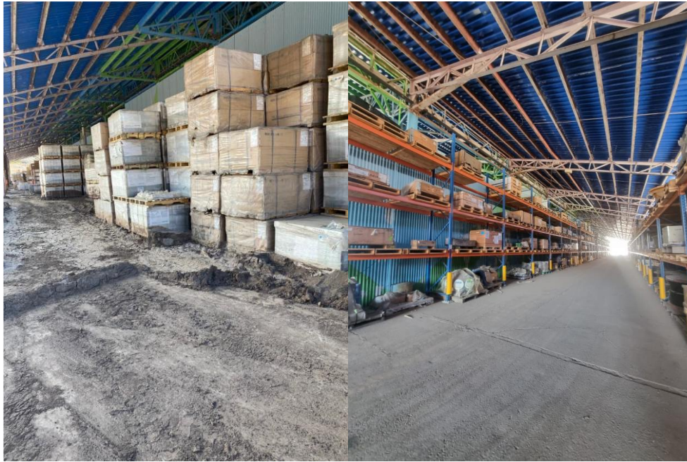
Figura N° 24. Bodega Patio Colón – Situación Inicial y Situación Posterior
