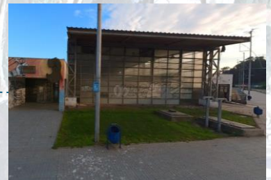
Fig. 6.13 Edificio Lonja Caleta Artesanal Puertecito.
