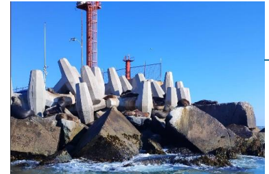
Fig. 6.7. Rompeolas Caleta Puertecito.
