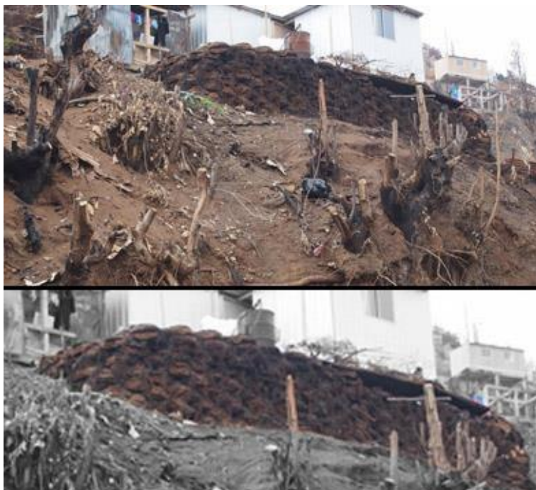
Figura 3-2 Muro de neumáticos quemado luego del gran incendio de Valparaíso del año 2014. Foto modificada de la fuente: (Ventana-verde.blogspot.cl, 2014).
