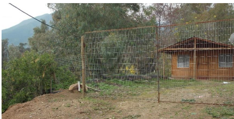
Figura 4-29 Superficie generada por la contención de muro, Machalí, Región de O'Higgins.
