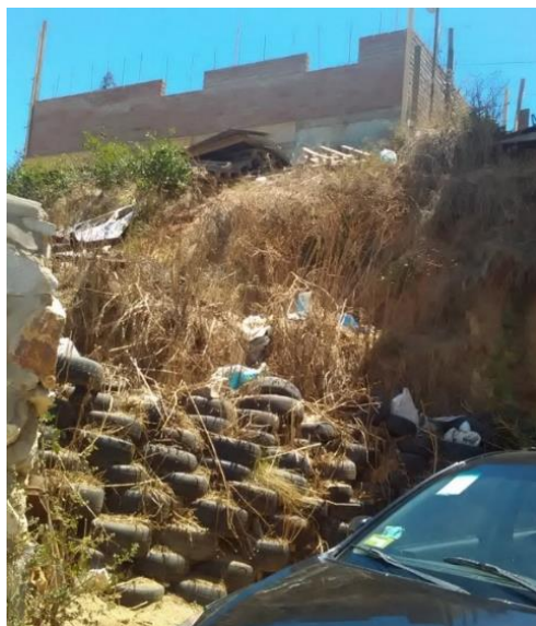
Figura 4-25 Apilado de neumáticos artesanal para afirmar terreno.
