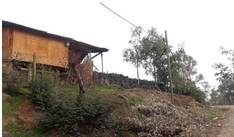
Figura 4-27 Muro de contención de neumáticos, Machalí, Región de O'Higgins.
