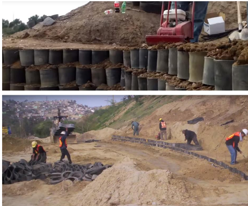
Figura 10-8 Colocación y compactación.
