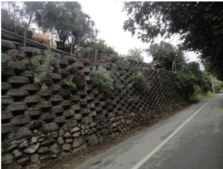
Figura 4-32 Muro de contención con neumáticos, sector "La Vega", Olmué. Cortesía de Tania Estay
