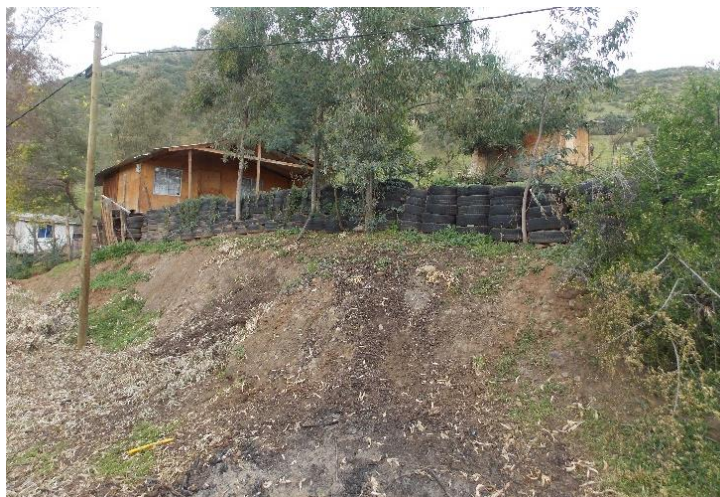
Figura 4-28 Muro de contención de neumáticos, otra vista. Machalí, Región de O'Higgins.
