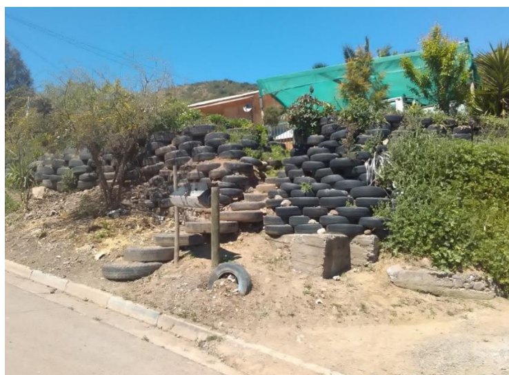
Figura 4-30 Muro de contención de neumáticos. Machalí, Región de O'Higgins.
