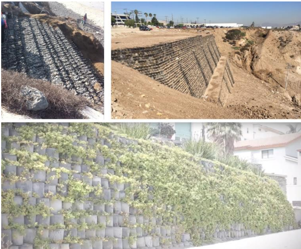
Figura 10-10 Muro a medio construir y muros finalizados.
