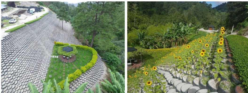
Figura 1-5 Estabilización de talud mediante el uso de neumáticos, Guatemala. Extraído de: https://www.facebook.com/ecomuroguatemala/
