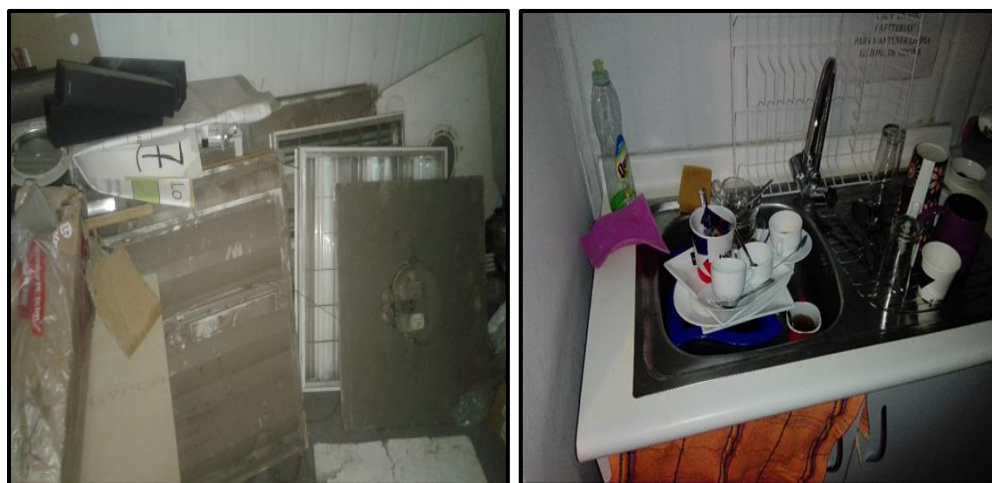
(a) (b) Figura 34. (a) Bodega Almacenamiento Of. Administrativa y (b) Sala Cafetería Edificio Gerencia, Calidad Administración, Planificación y Ventas.
