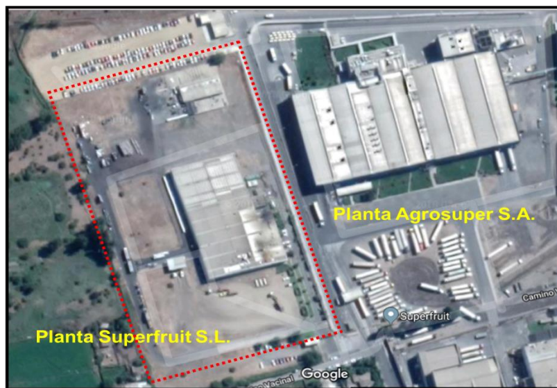
Figura 3. Vista Aérea Superfruit, Planta Lo Miranda
