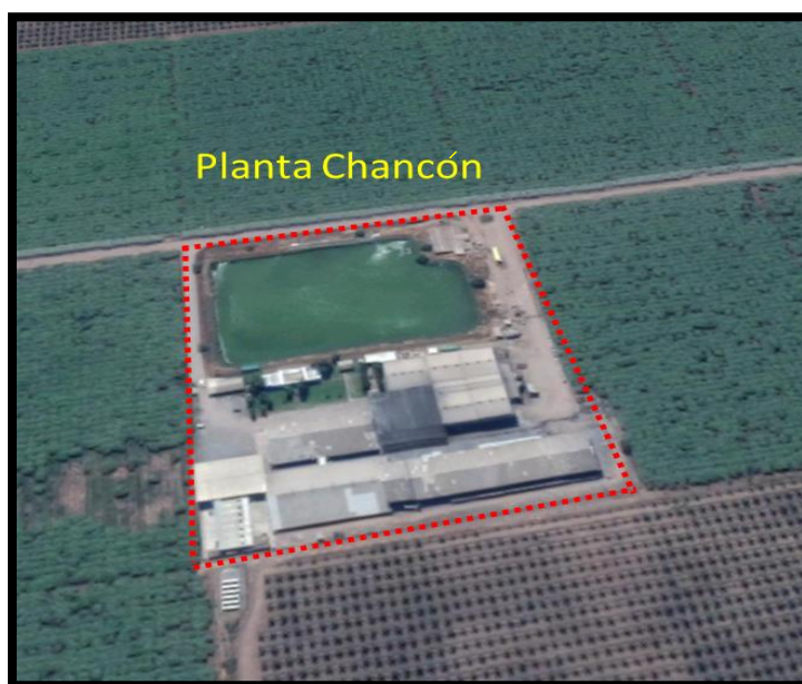
Figura 1. Vista Aérea Planta Chancón y Canchas de Secado Ciruelas
