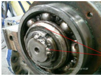
Figura 1.42 Soldadura para fijación de tuerca que afianza el conjunto rotante.
