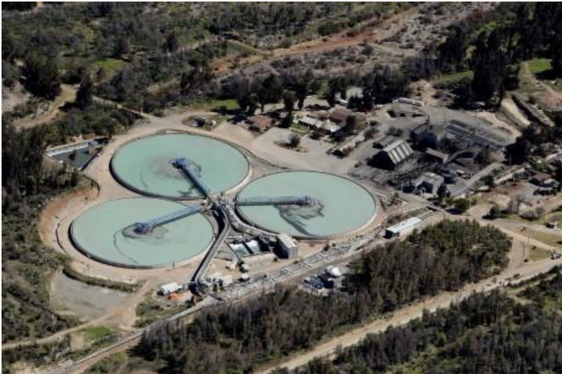
Figura 1.20, Vista aérea planta RAI de MVC, se distinguen los espesadores, la planta de preparación de floculante, las piscinas y bombas de agua clara (RABI)
