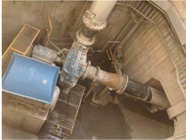
Figura 1.22, Bomba Warman 18x16x36 descarga espesador.
