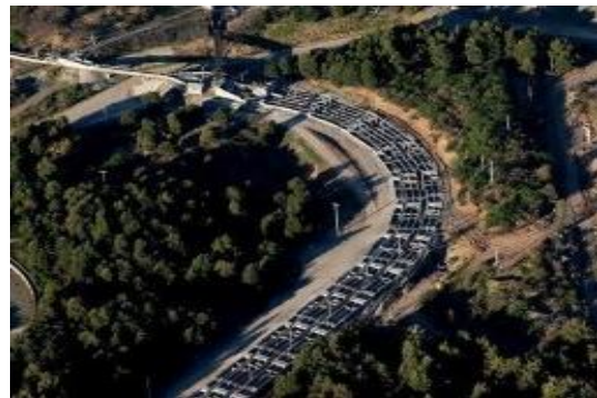
Figura 1.13, Vista aérea cascadas de flotación
