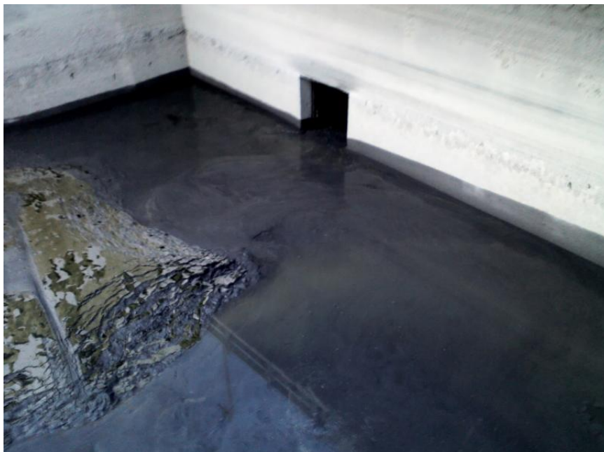
Figura 1.46, Piscina alimentación bombas de sala 2 vaciada para limpieza.
