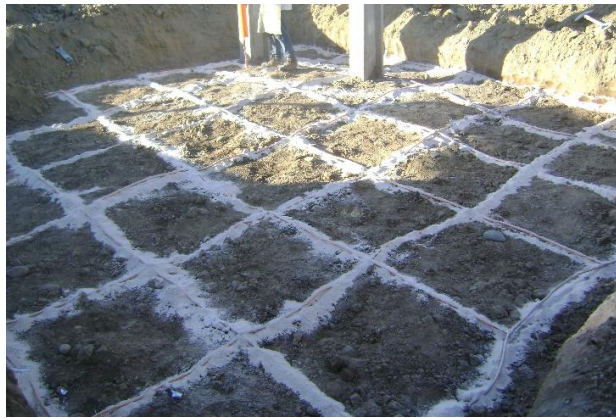
Figura 1-6 Construcción Malla Tierra
