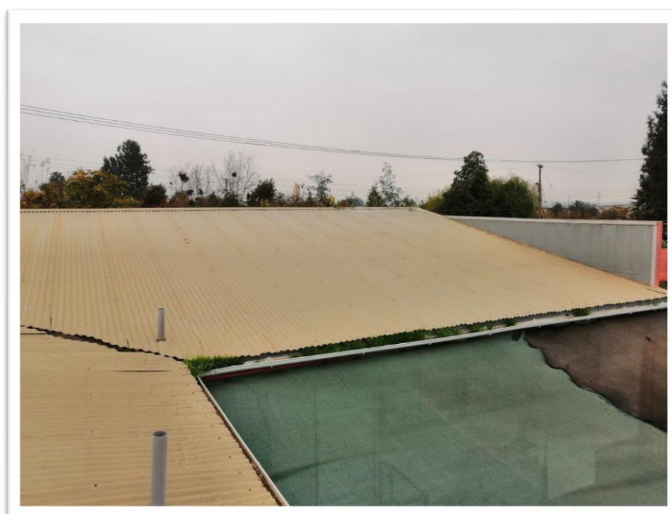
Fuente: Elaboración propia. Figura 1-12. Vista del Lado Este desde más atrás.
