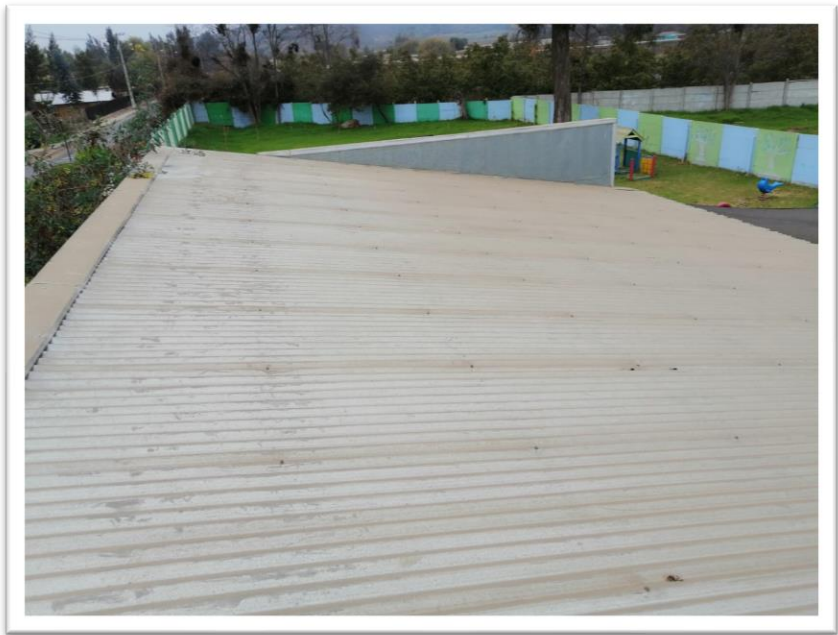
Fuente: Elaboración propia. Figura 1-8. Techo del Jardín, lado Este.
