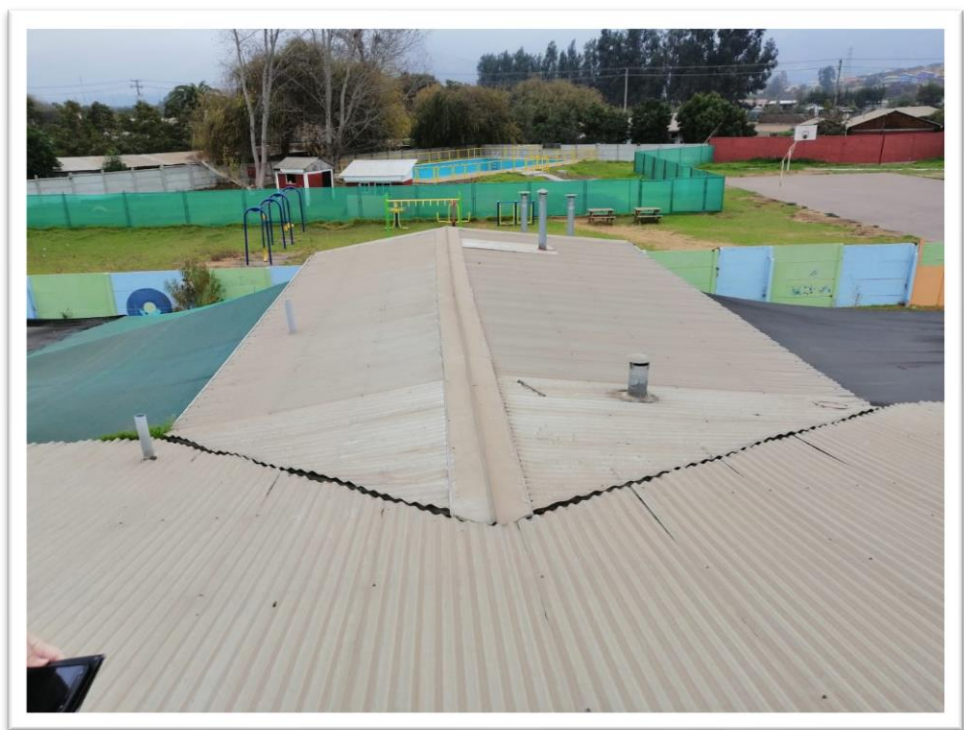
Fuente: Elaboración propia. Figura 1-13. Vista del techo orientación Sur.
