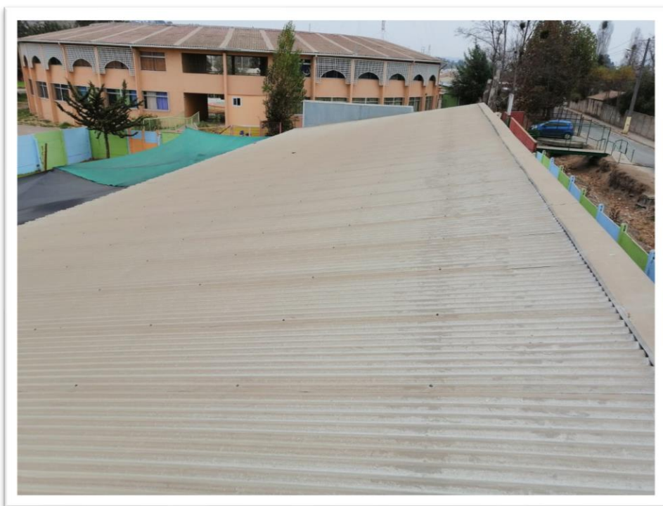
Fuente: Elaboración propia. Figura 1-9. Techo del Jardín, lado Oeste.
