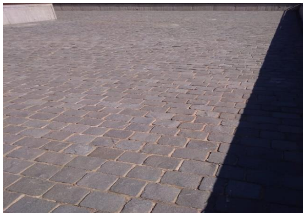
Figura 3.8.2: Material terraza quinto piso edificio de difusión.
