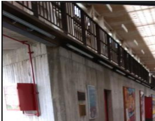
Figura 3.4.2: Luminaria actual edificio transmisión.
