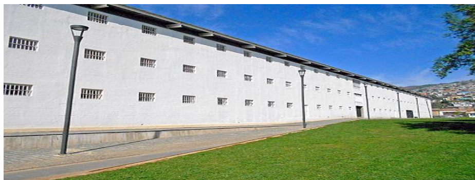
Figura 3.1.3: Edificio Transmisión PCdV.
