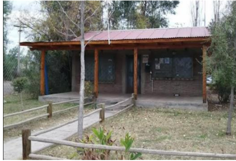
Figura 3-8. Oficina sector ingreso.
