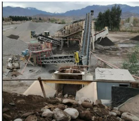
Figura 3-3. Planta de ripio, arena y gravilla.
