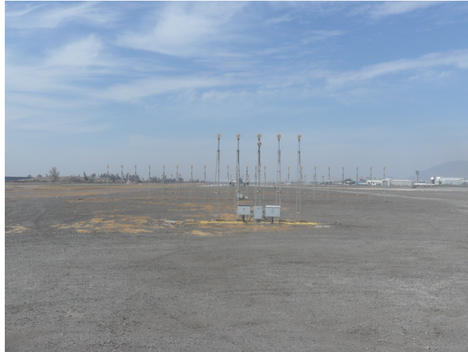
Figura 3.4: Luces de Aproximación Pista 17L.
