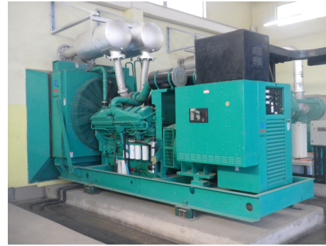
(b) GN3 Cummins 1000 kVA
