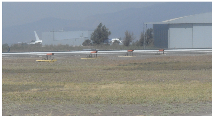
Figura 3.5: Luces Indicadoras de Pendiente de Aproximación (PAPI) Pista 17L. (Fuente: Dirección General de Aeronáutica Civil, 2019))
