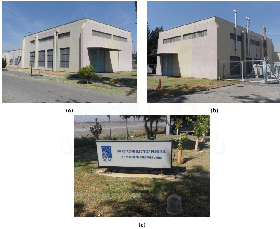
Figura 7.1: Subestación Eléctrica Principal (Fuente: Dirección General de Aeronáutica Civil, 2019)
