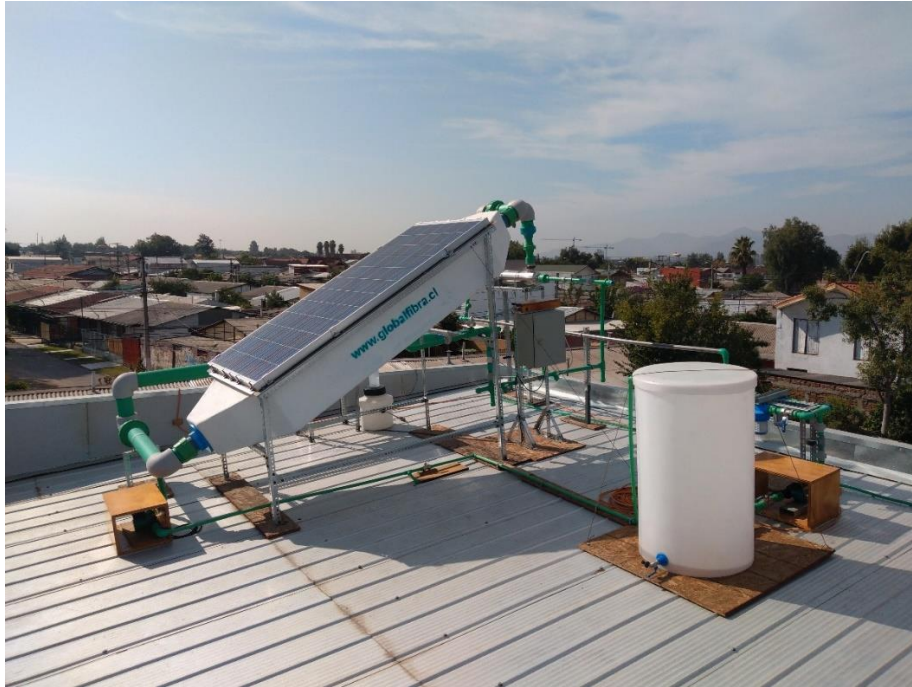
Figura 4.22. Vista Sureste de planta HDH.
