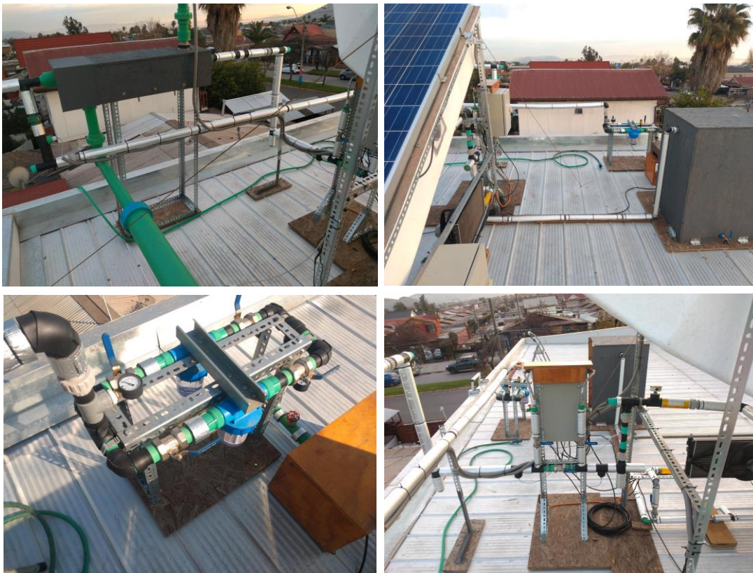
Figura 6.3. Aislación de tuberías de 20-32 mm, cobertura de estanque y cobertura de condensador.
