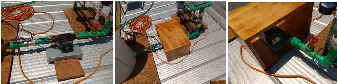
Figura 4.15. Instalación de Bombas. Izquierda, bomba de alimentación. Centro y derecha, disposición con protector.
