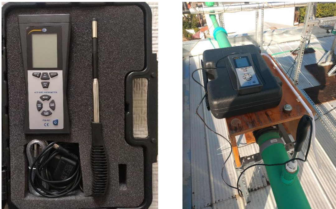
Figura 5.21. Anemómetro. Izquierda, modelo PCE-423 en su caja. Derecha, toma de mediciones en la planta.
