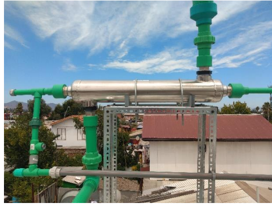
Figura 4.9. Construcción Humidificador. Izquierda, estructura de soporte con perfil de fijación. Derecha, instalación conectada al piping de agua y aire.
