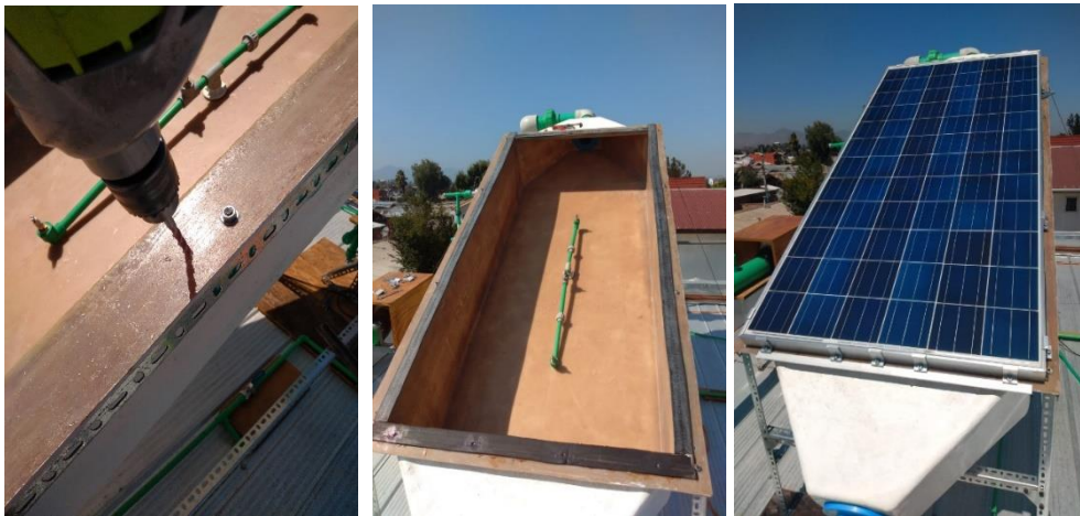
Figura 4.8. Construcción del humidificador. Izquierda, perforación para grapas con broca M8. Centro, adhesión de sello de goma. Derecha, instalación de PV.
