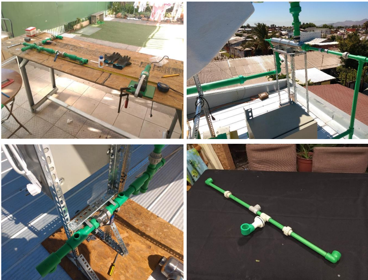
Figura 4.12. Construcción piping agua. Arriba izquierda, estación de trabajo para termofusión. Abajo, bypass calentador auxiliar y ramal de aspersores mejorado.
