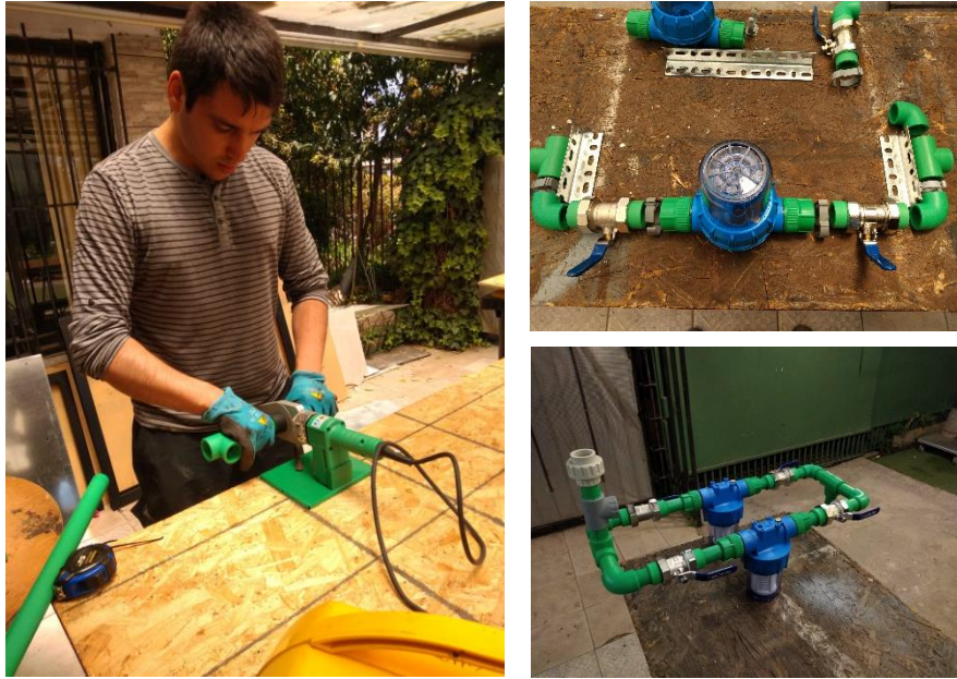
Figura 4.11. Construcción de piping de agua. Izquierda, proceso de fusión. Derecha arriba, ubicación de fittings para bypass de filtros. Derecha abajo, sistema de filtros casi terminado.
