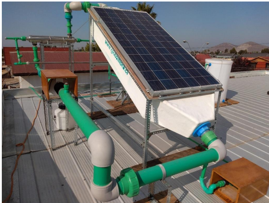
Figura 4.21. Vista Suroeste de planta HDH.
