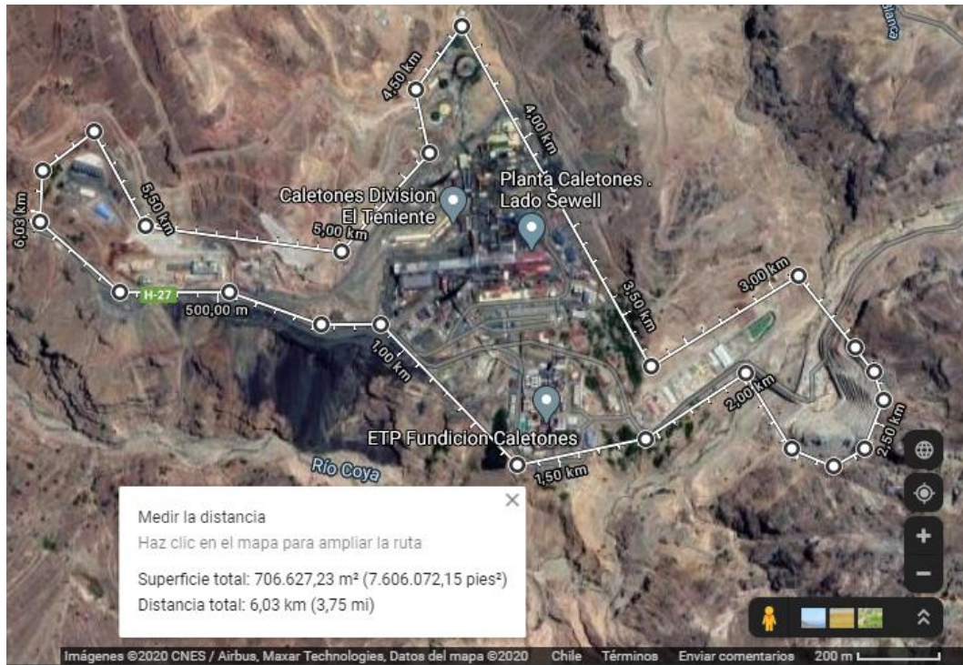
Figura 2.15 Área de operaciones de Fundición Caletones, División El Teniente, CODELCO [13].
