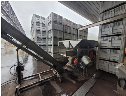
(d) Despalilladora de la línea Confluencia.
