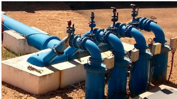
FIGURA 1-2. TUBERÍAS DE SUCCIÓN E IMPULSIÓN
