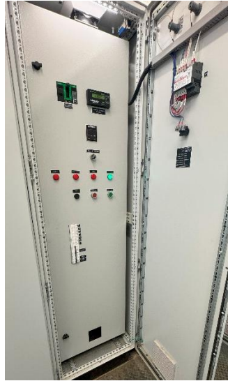
FIGURA 1-8. TABLERO DE FUERZA Y CONTROL BOMBAS.
