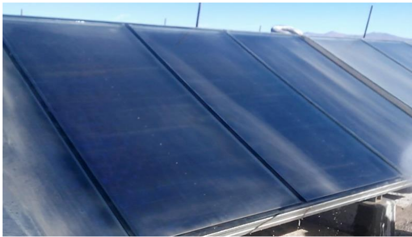
Figura 25: Resultado método con Vapor de agua a presión, sin secado
