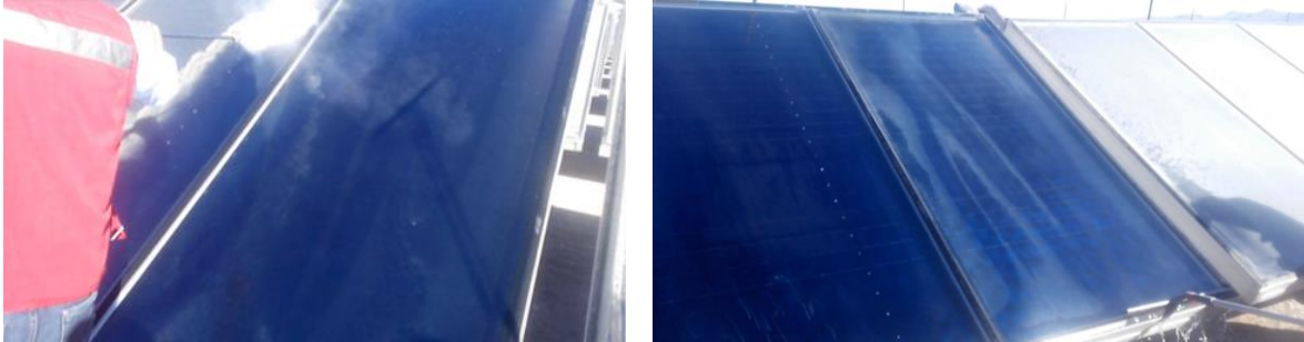
Figura 23: Colectores durante y después de la limpieza con agua fría y secado
