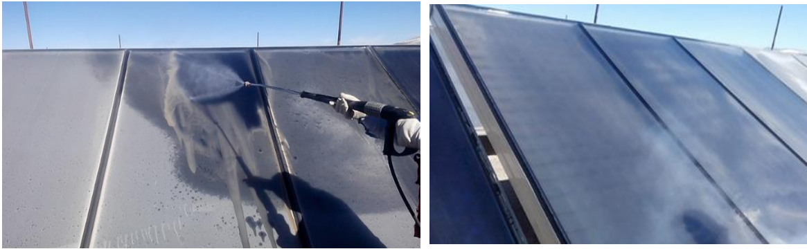
Figura 20: Colector durante la limpieza
