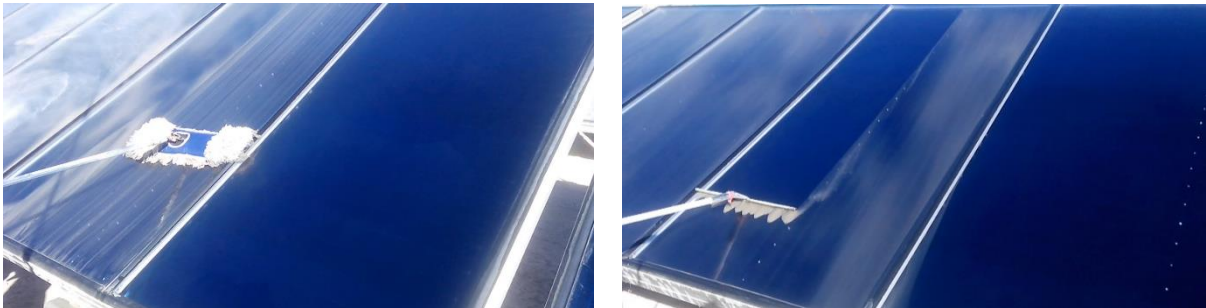
Figura 24: Colectores limpiados con elemento abrasivo, agua fría y secado
