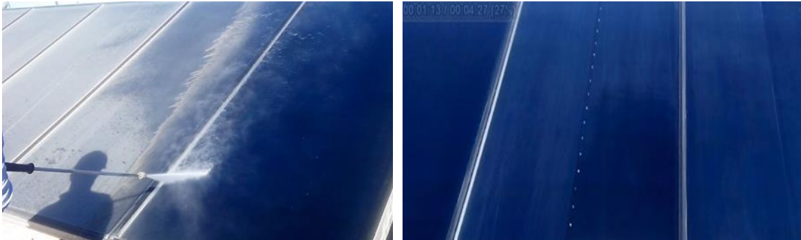
Figura 22: Colectores durante y después de la limpieza con agua caliente y secado
