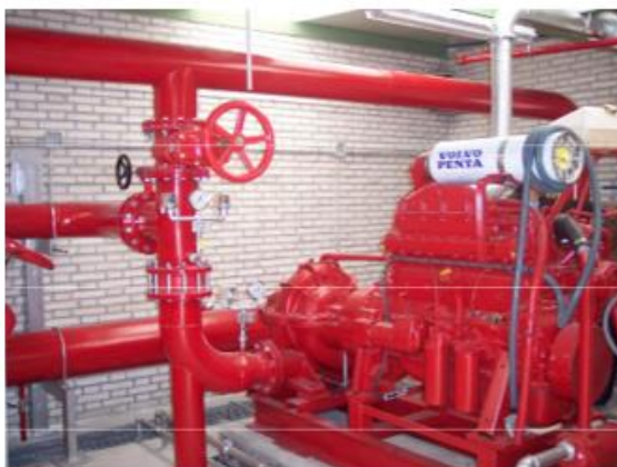
Ilustración 3. Bombas eléctricas y de Diesel pertenecientes al SPCI. (Pefipresa 2015, sistemas de protección contra incendios en Túneles).
