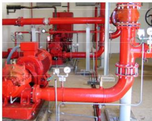
Ilustración 3. Bombas eléctricas y de Diesel pertenecientes al SPCI. (Pefipresa 2015, sistemas de protección contra incendios en Túneles).
