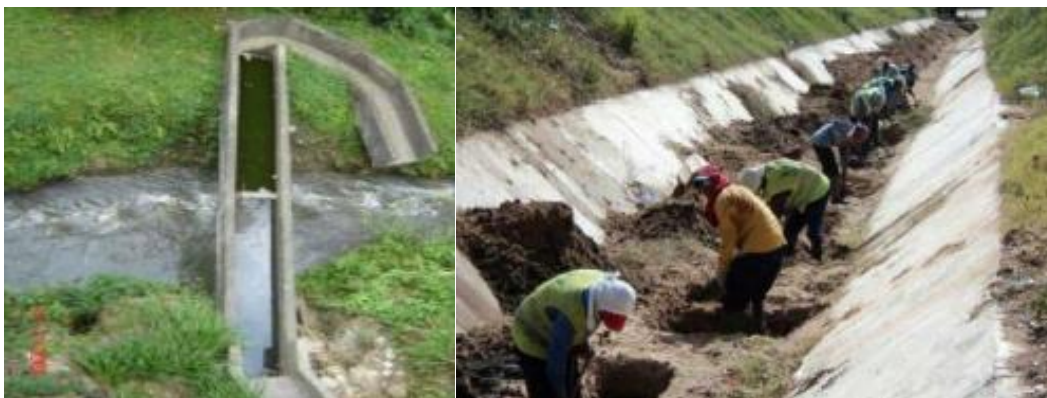
Ilustración 26. Ejemplo de estructura de entrega (izquierda) y obstrucción (derecha) en colectores. (Arriagada y Echaveguren; Manual de Inspección Visual de Activos de Saneamiento y Drenaje de Carreteras).
