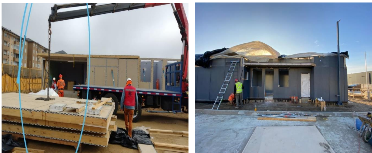
Figura 1-4.- Copec Curauma. Estructura prefabricada y montable en 5 días.
