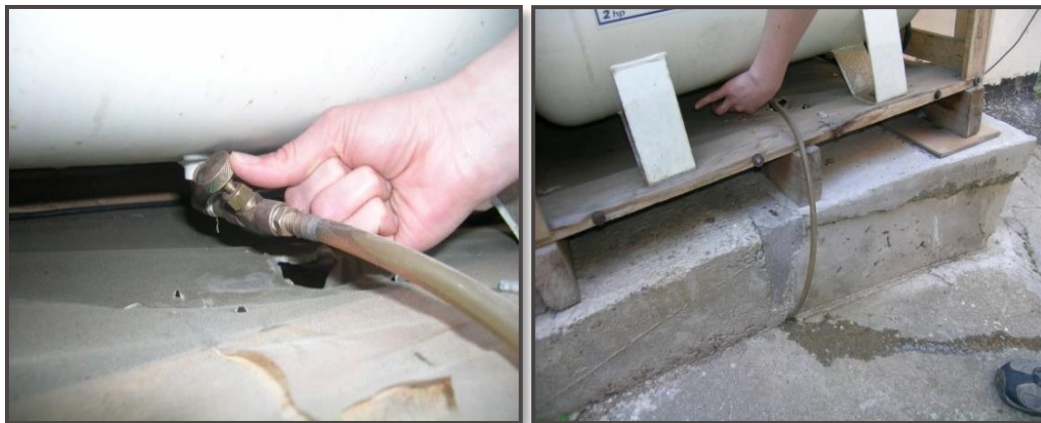
Figura 5.52 Despiche compresor C-1.
