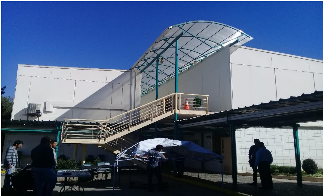
FIGURA 3-4: VISTA DESDE PATIO CENTRAL DEL EDIFICIO G.
