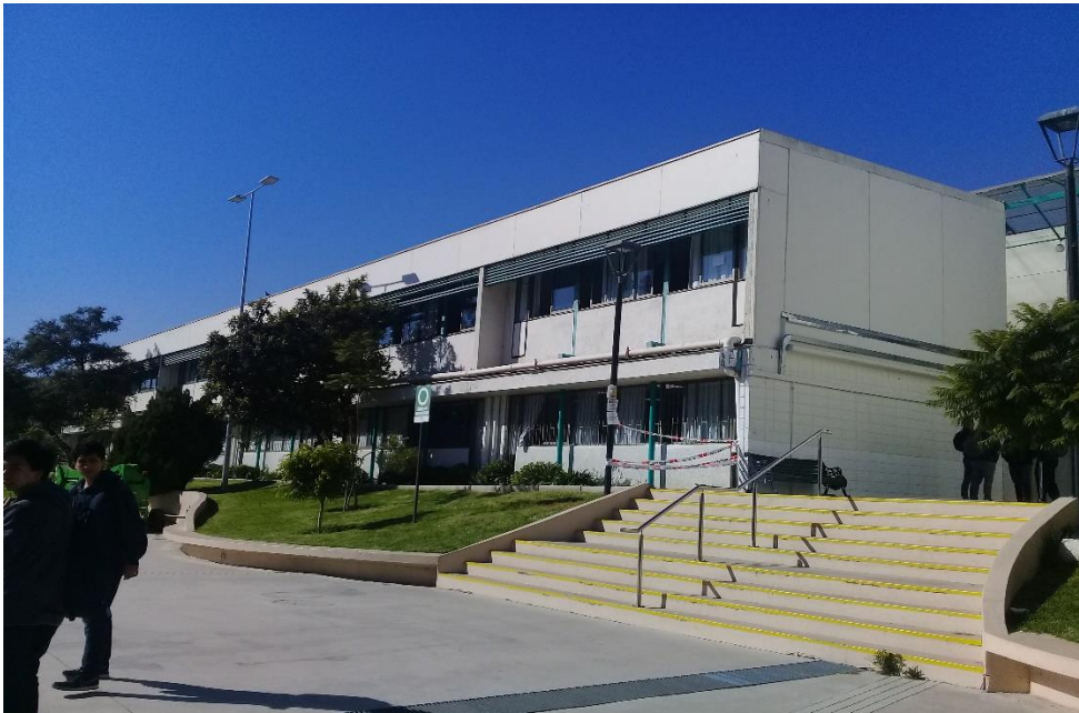
FIGURA 3-3: FRONTIS EDIFICIO G
