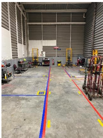
Imagen 4-17. Pasillo central de Estaciones de Trabajo.
