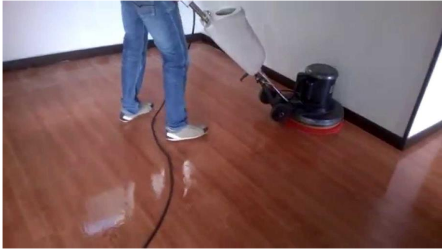
Figura 3-7: Fregado del piso
