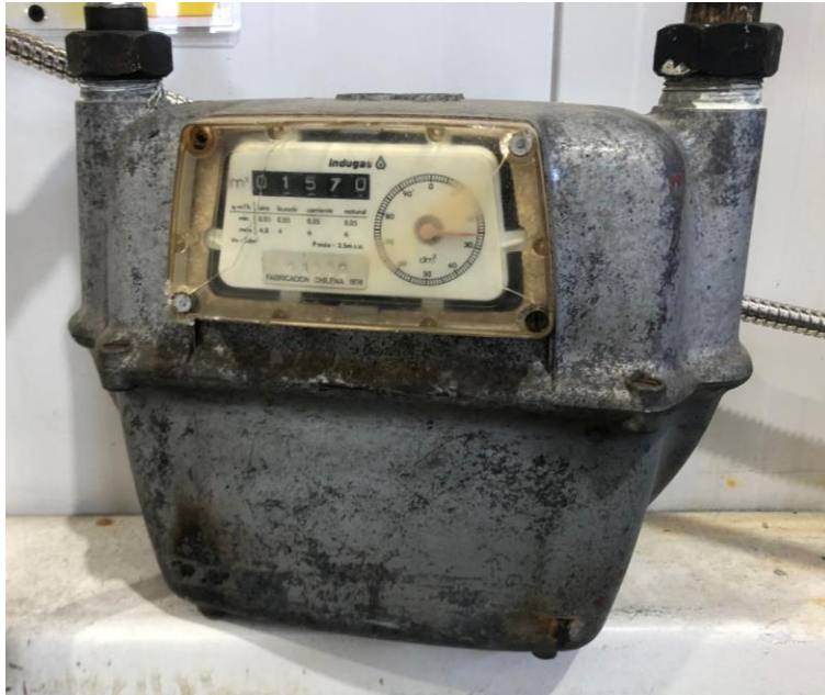
Figura 3.14: Medidor de consumo para GLP.
