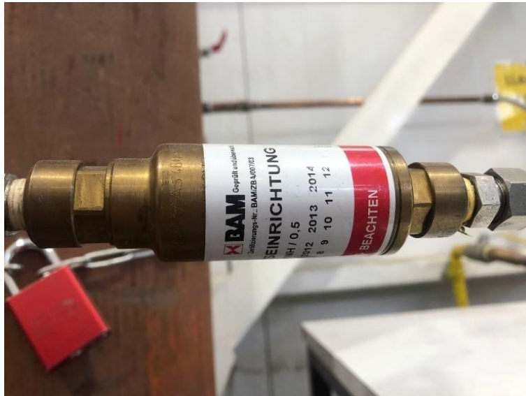
Figura 3.12: Válvula antirretorno.
