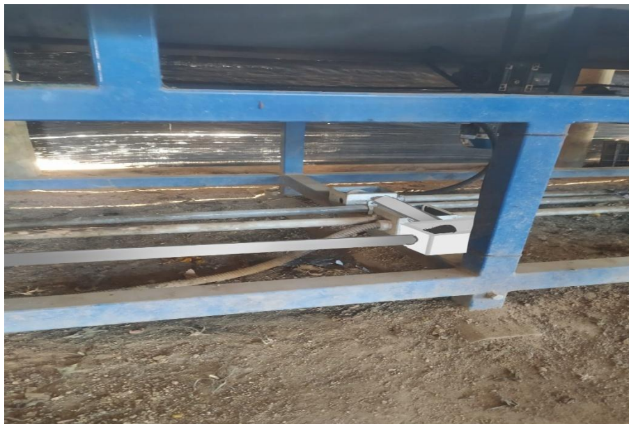
Diseño 5: “Tubería Emt 20 mm, caja galvanizada, conexión a motor – confeccionado por diseñadora gráfica”
