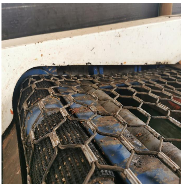
Foto 17: “Separación entre malla y la carcasa de contención - confección propia”
