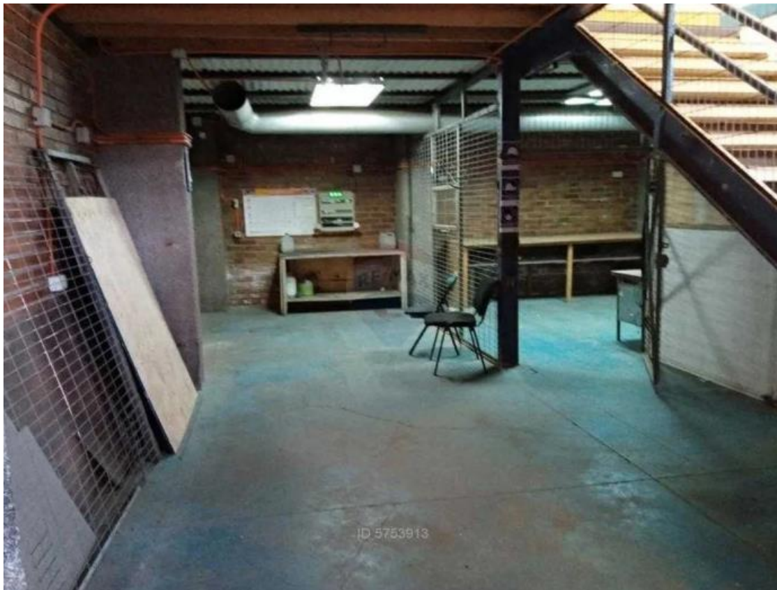
ILUSTRACIÓN 2-5 "TALLER Y SALA DE MOTORES"
