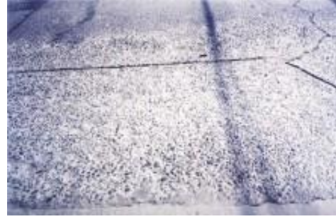
Imagen 16: Fisuras y grietas transversales
