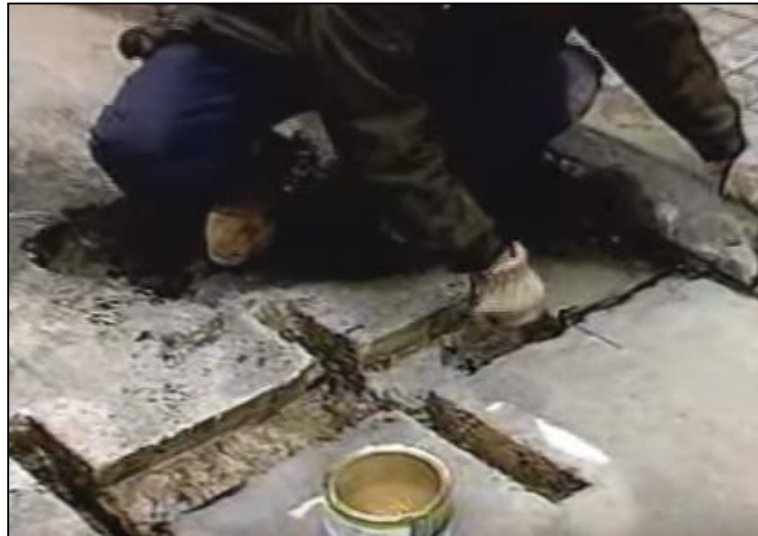
Imagen 6: Reparación de espesor parcial
