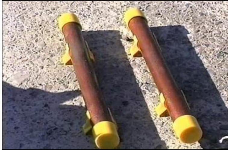
Imagen 8: Barras de transferencia de carga, con tapas de expansión plásticas en los extremos, sostenidas en sillas.
