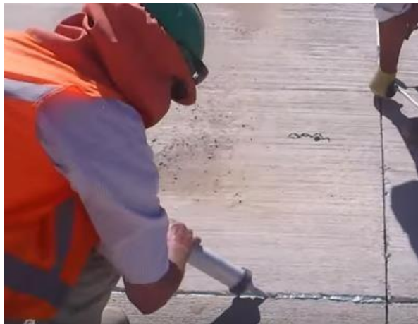
Imagen 5: Sellado de juntas y grietas
