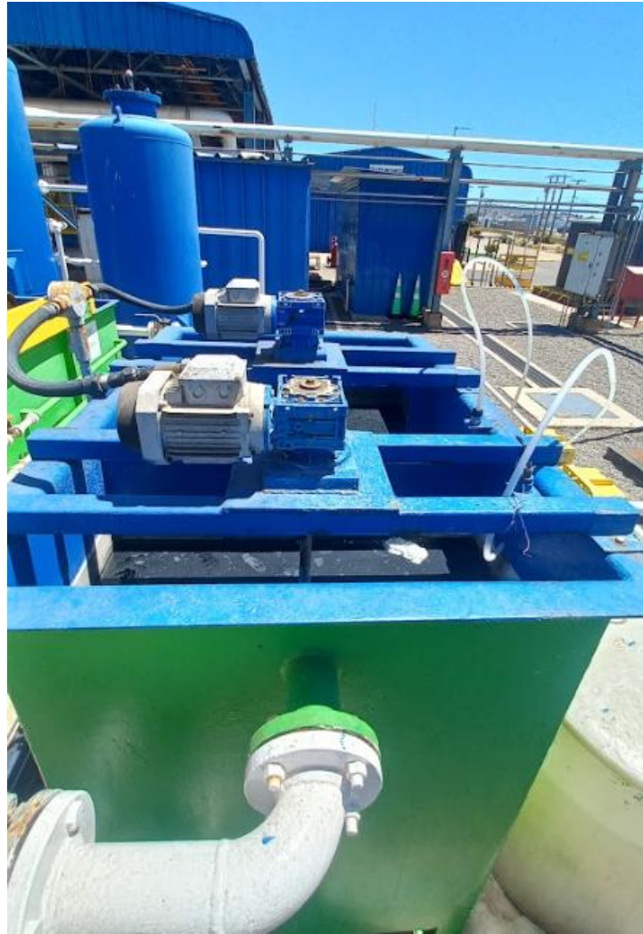
Figura 10: Circuito coagulante y floculante
