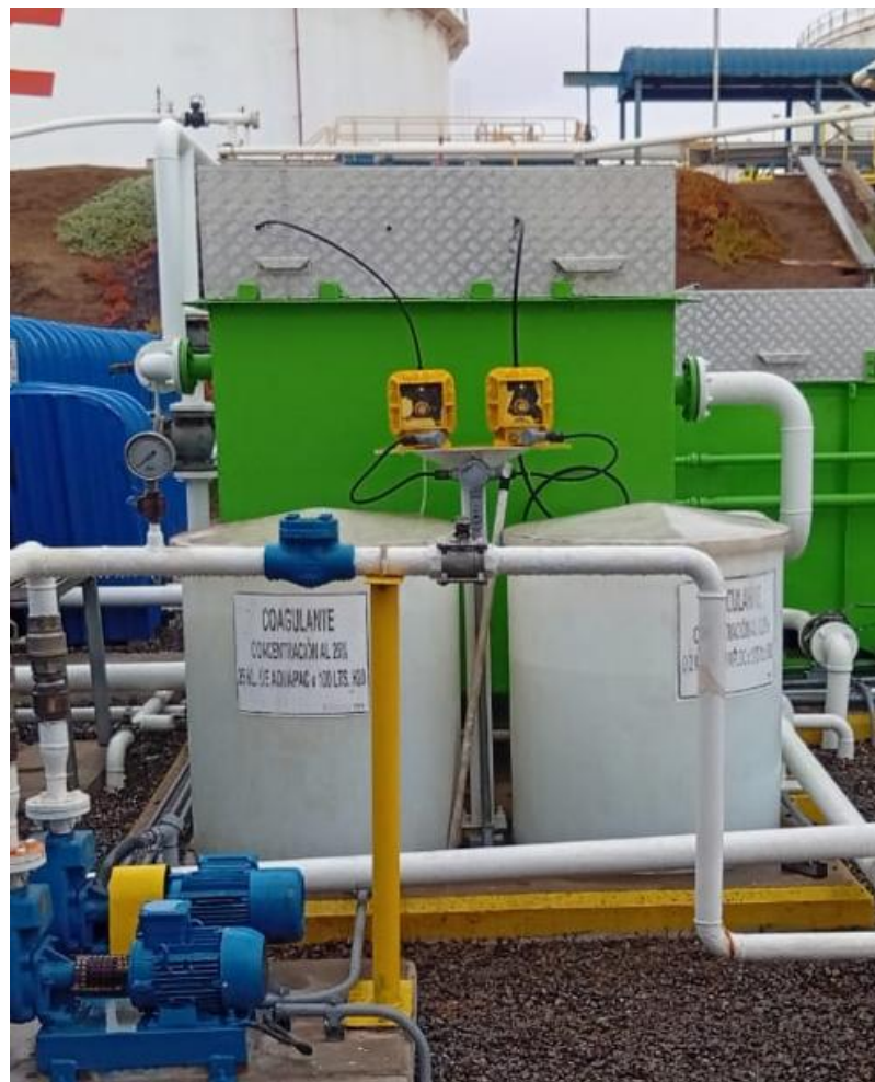
Figura 9: Circuito coagulante y floculante
