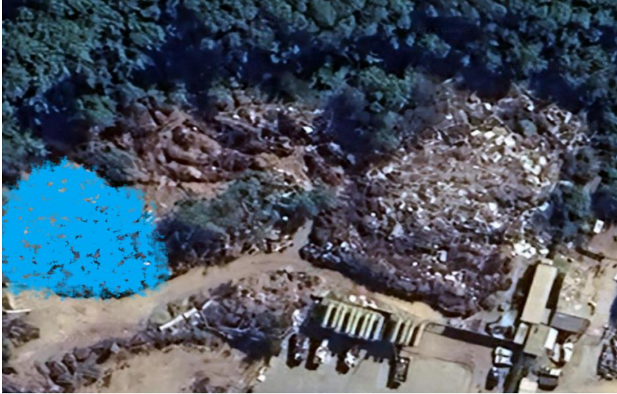
Figura 2-3 Vista aérea Planta de compostaje “Zona residuos varios”
