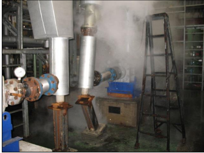
Fig. 10-5 Juntas en succión de bomba.
