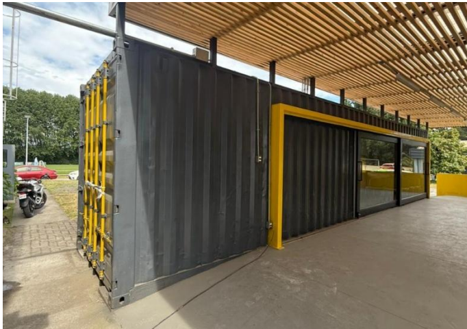
Imagen 5: Vista exterior, muro frontal de primer piso, recinto 2 Fuente: Elaboración propia
