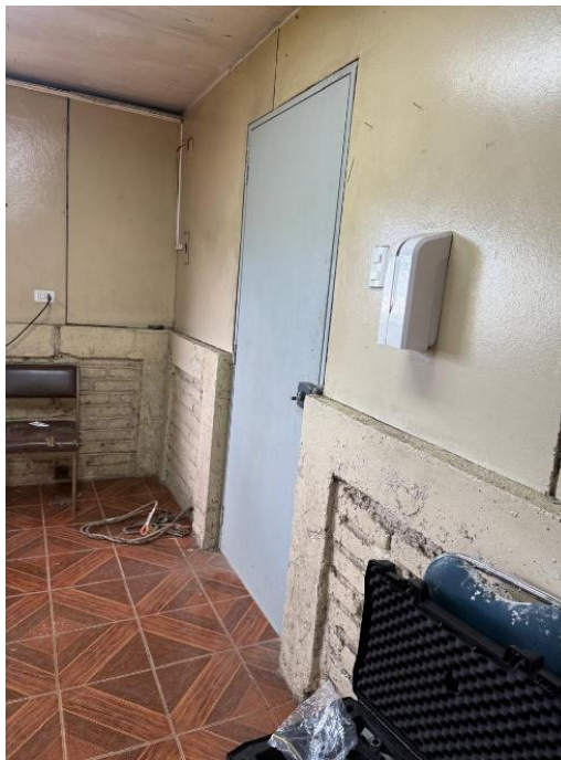
Imagen 2: Vista interior, muro frontal de primer piso, recinto 1 Fuente: Elaboración propia
