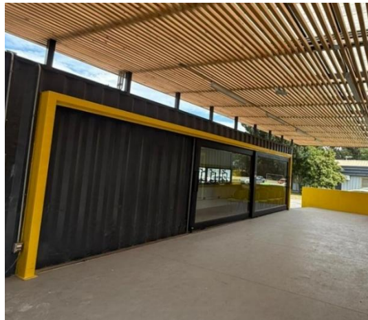
Imagen 6: Vista exterior, muro frontal de primer piso, recinto 2 Fuente: Elaboración propia
