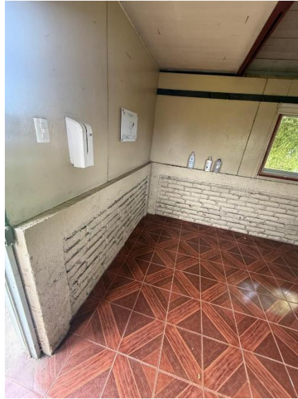
Imagen 3: Vista interior, muro frontal de primer piso, recinto 1 Fuente: Elaboración propia
