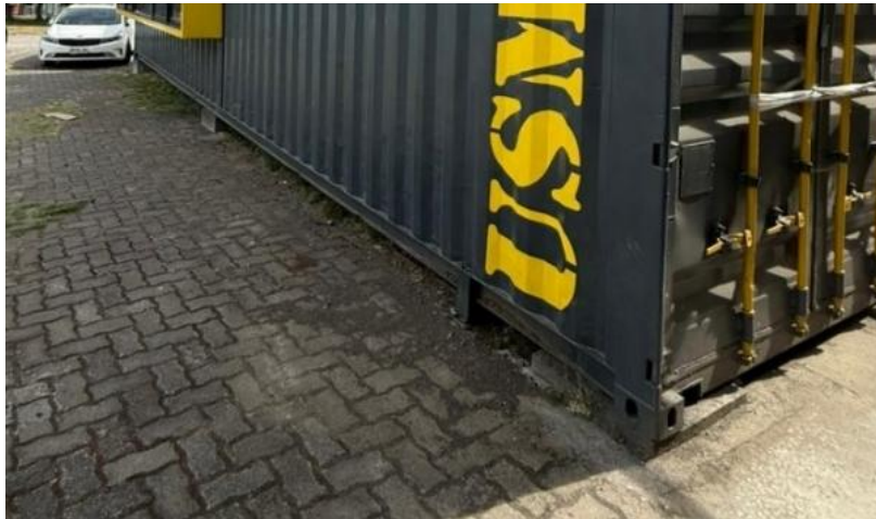
Imagen 7: Vista exterior, Piso elevado, recinto 2 Fuente: Elaboración propia
