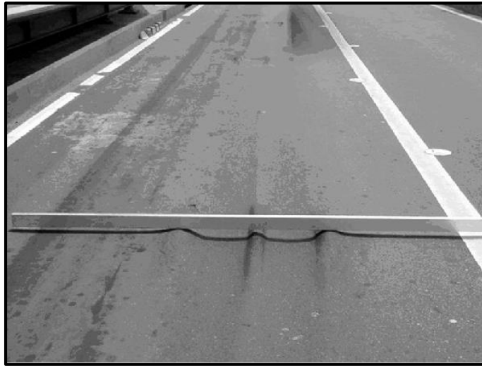
Figura 2-3: Ahuellamiento.
