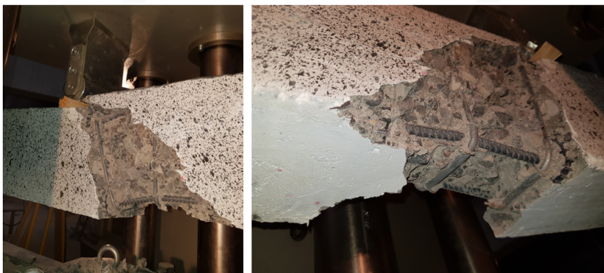
Figura 4.23: Viga 1 - Desprendimiento del hormigón e inspección de los estribos.
