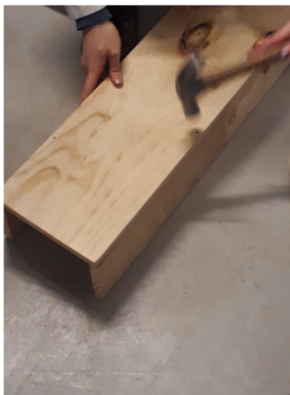
Figura 4.3: Preparación del moldaje.
