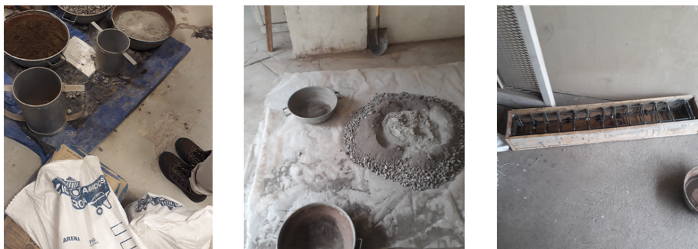
Figura 4.5: Preparación de la mezcla para el hormigón.
