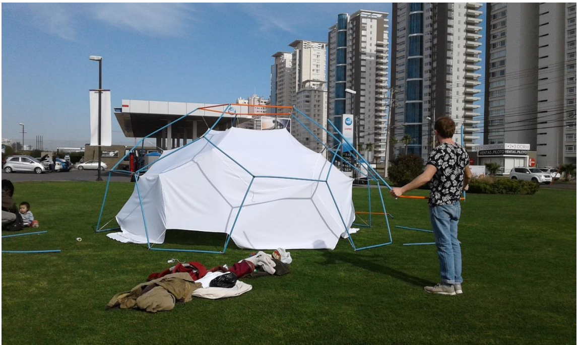
Proceso de montaje telón cubierta
