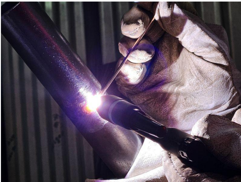
Ilustración 3-6: soldadura de tubos
