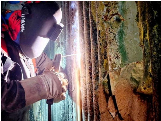
Ilustración 3-9: soldadura en caldera
