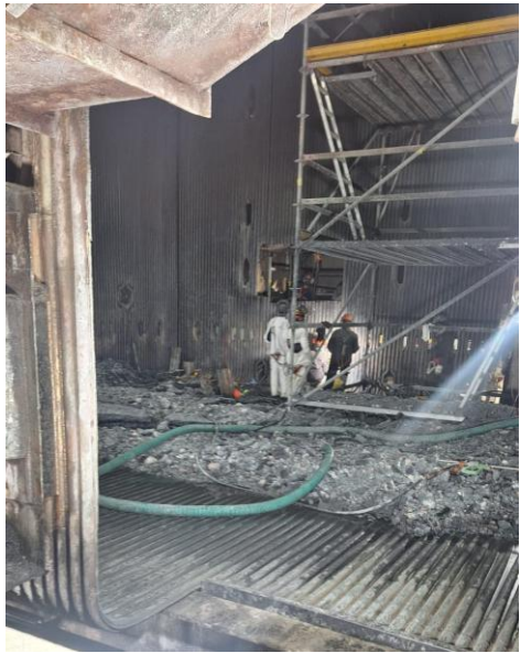
Ilustración 3-3: Trabajos en interior de caldera
