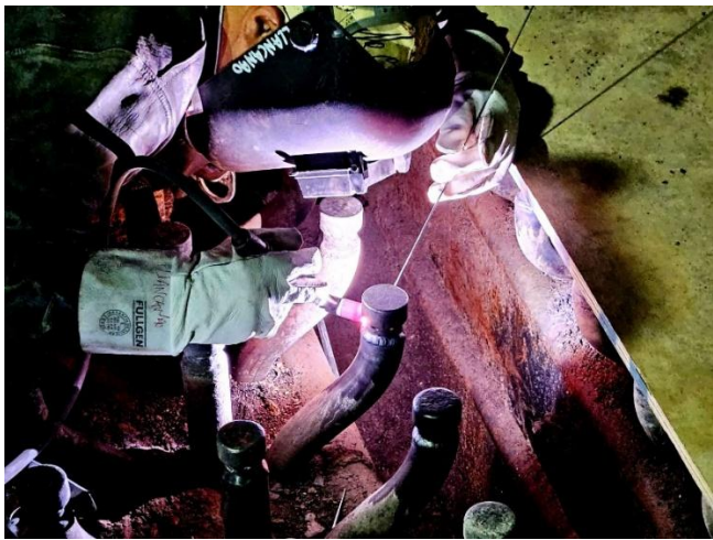
Ilustración 1-2: soldadura en terreno
