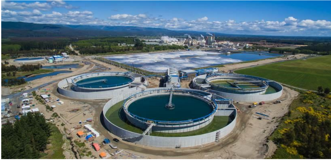
FIGURA 1.2: Sector planta tratamiento efluentes, Celulosa Arauco Horcones.
