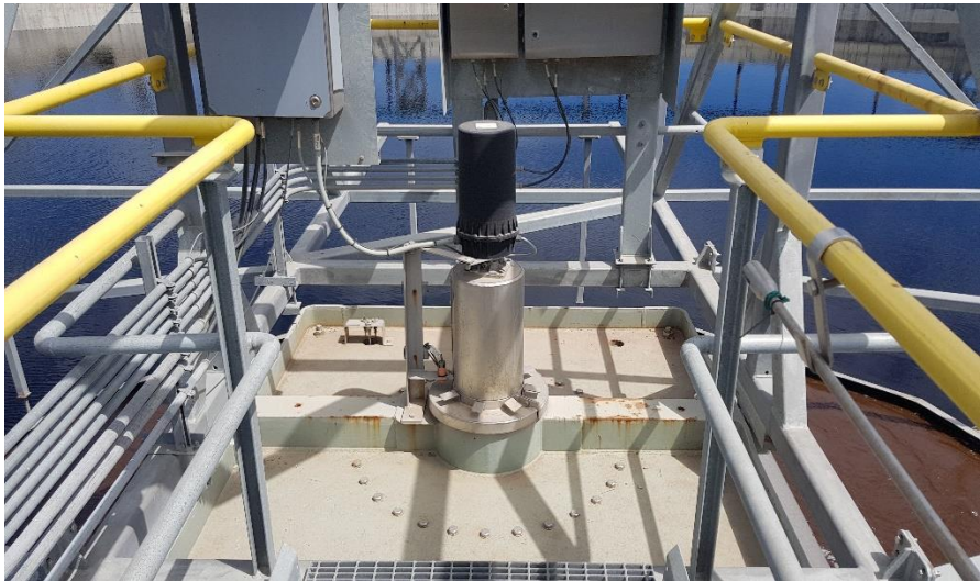
FIGURA 3.7: Sistema central, lubricación brazos accionadores de rastra.
