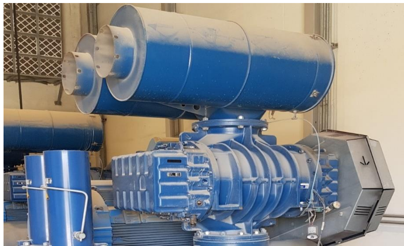
FIGURA 3.5: Soplador de desplazamiento positivo.
