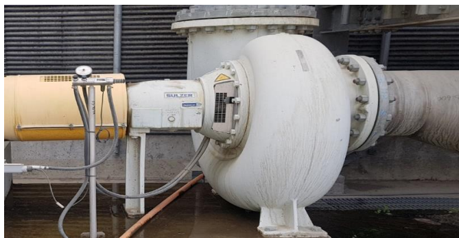
FIGURA 3.6: Bomba centrífuga.
