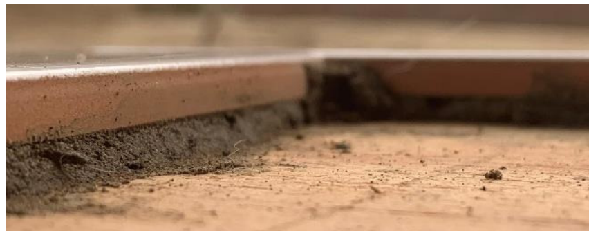
Fig. 32 - Espesor adhesivo con fibras y polvo
