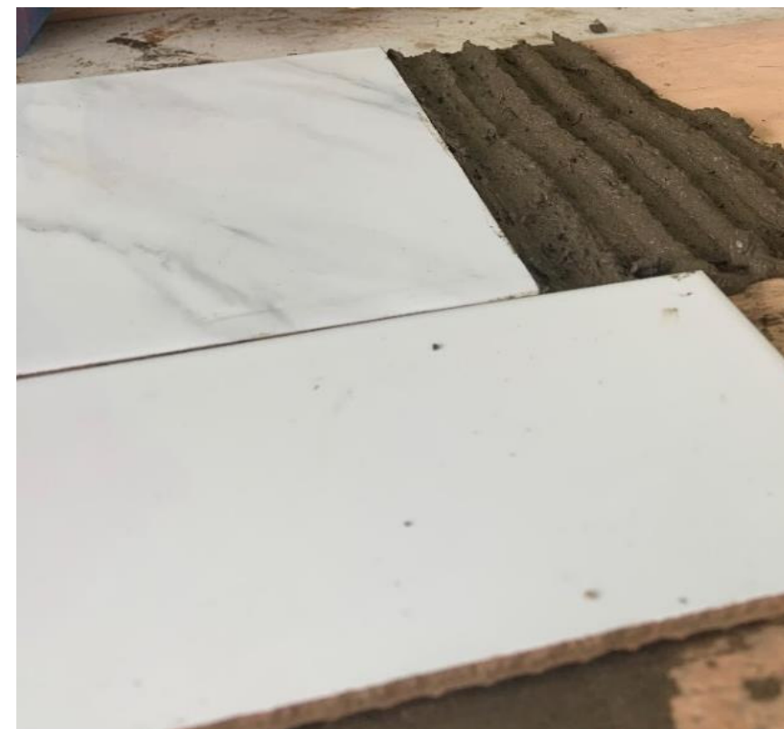
Fig. 30 - Cerámicas sobre adhesivo con fibras y polvo de caucho
