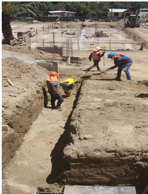
Figura 2-22: Llenado de maicillo a muros divisorios
