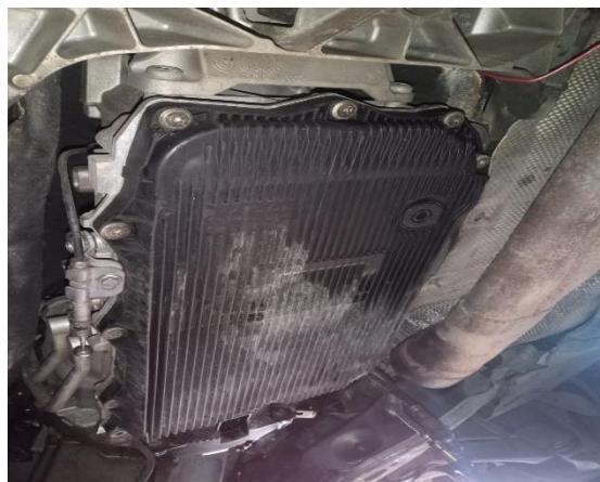
Figura 3- 2: Tapón de vaciado identificado
