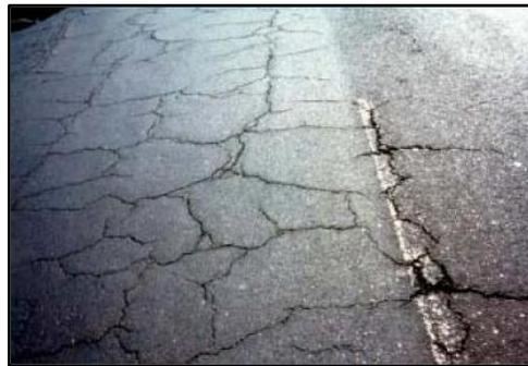
**Figura 2.4** Pavimento flexible que presenta agrietamiento por fatiga [27].
