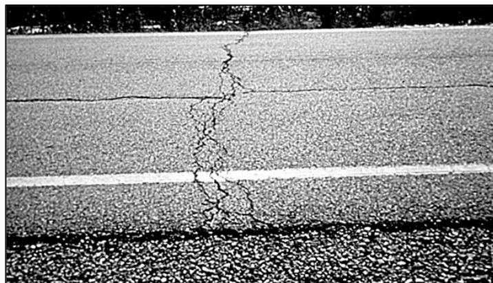
*Figura 2.2 Agrietamiento térmico en pavimento flexible. [27]*
