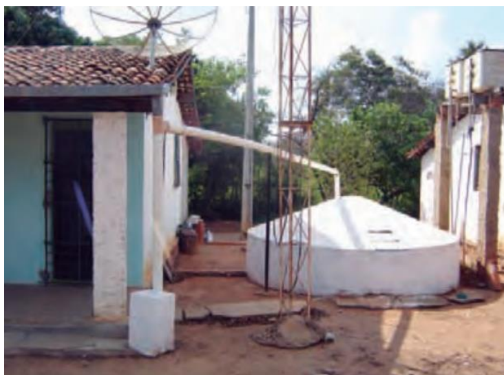
Figura 4: Sistema de captación de agua lluvia en el techo de una vivienda, con su correspondiente estanque de almacenamiento para uso doméstico.
