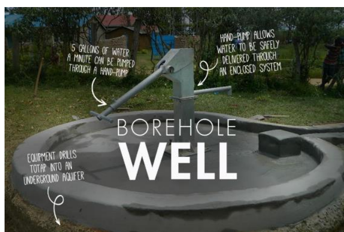
Figura 2: Explicación de funcionamiento del pozo perforado (The Water Project Inc.).
