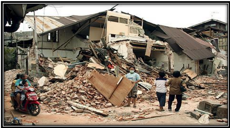
Figura 1-9 Derrumbe de una vivienda a causa del terremoto.
