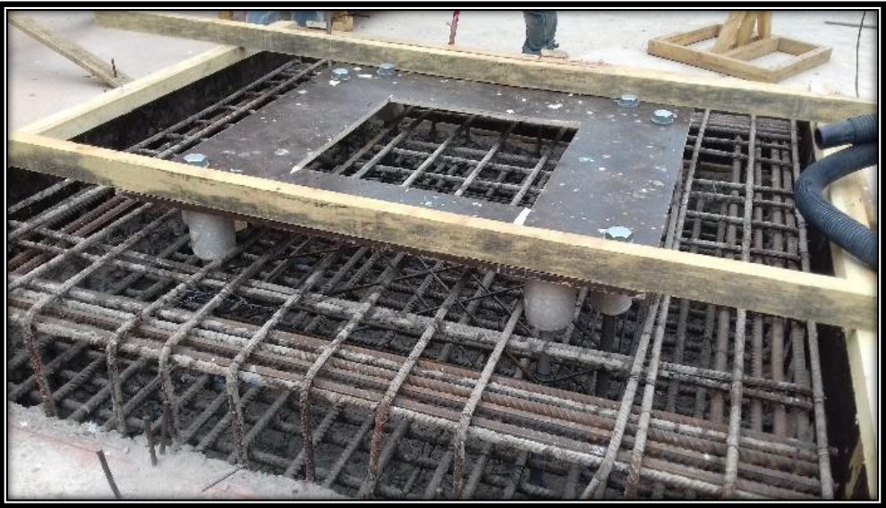
Figura 2-7 placa de acero posicionada en la armadura, lista para vaciado del hormigón. (secuencia constructiva).
