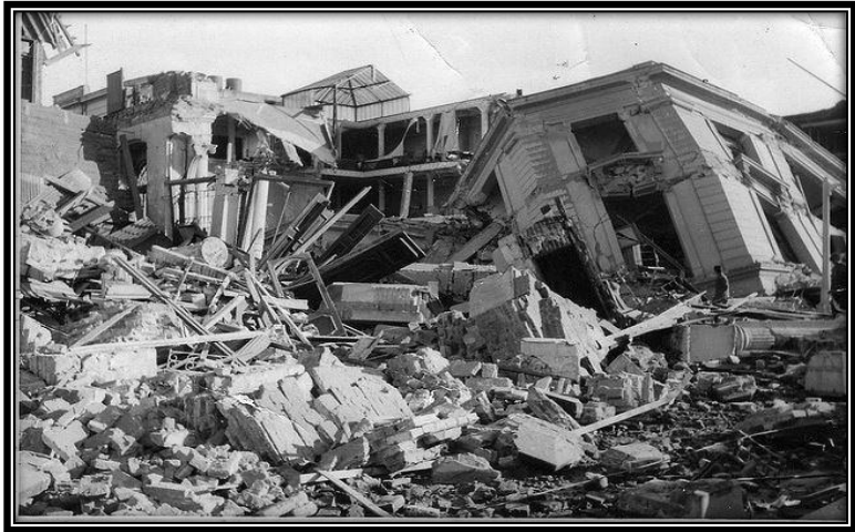
Figura 1-12 Daños del terremoto de rusia.
