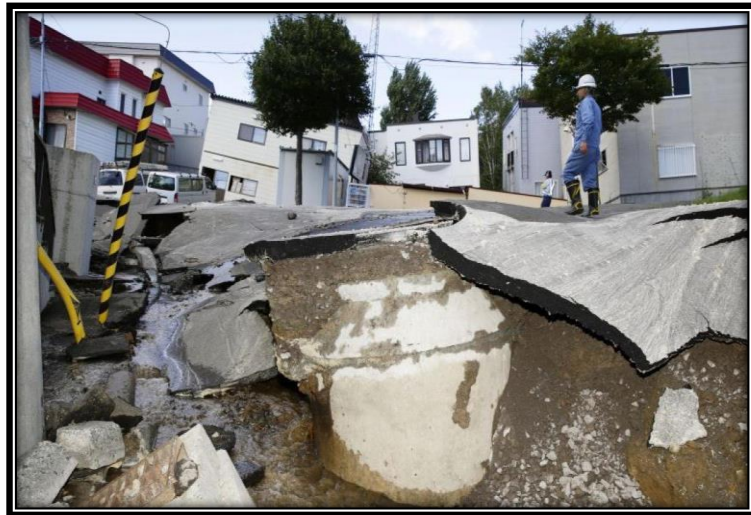
Figura 1-11 fotografía de las calles destruidas después del terremoto.
