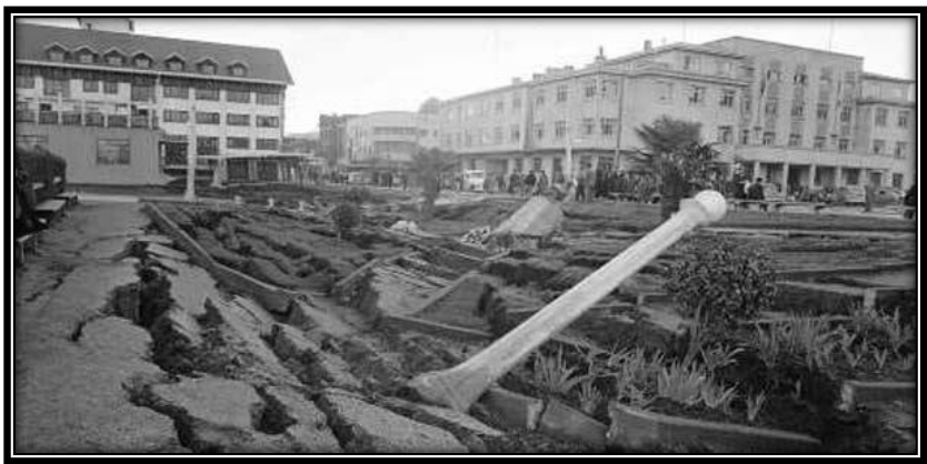
Figura 1-13 Suelo totalmente agrietado a causa del terremoto de 1952.
