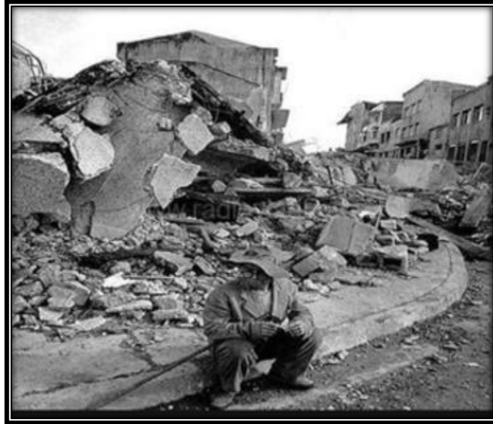
Figura 1-7 Fotografía de los daños causados por el terremoto de Valdivia en 1960, Chile.
