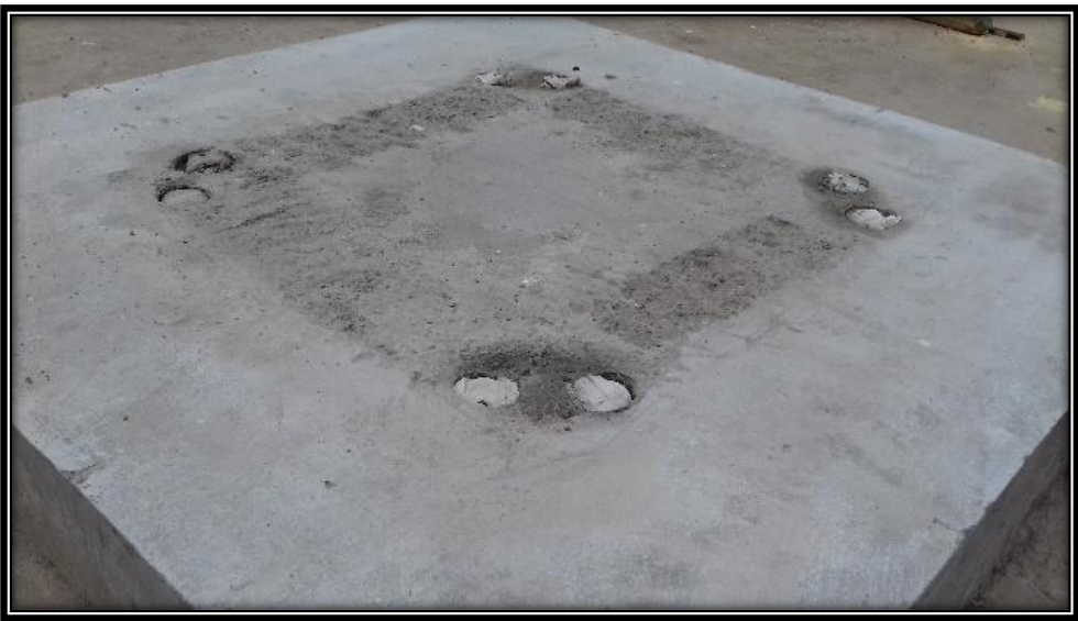
Figura 2-8 Detalle de dado de hormigón H-40, base de los aisladores sísmicos.
