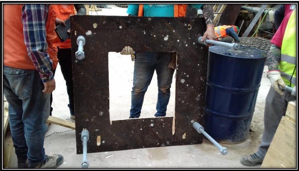
Figura 2-5 Vista inferior de una placa de acero para la base de los aisladores (secuencia constructiva).
