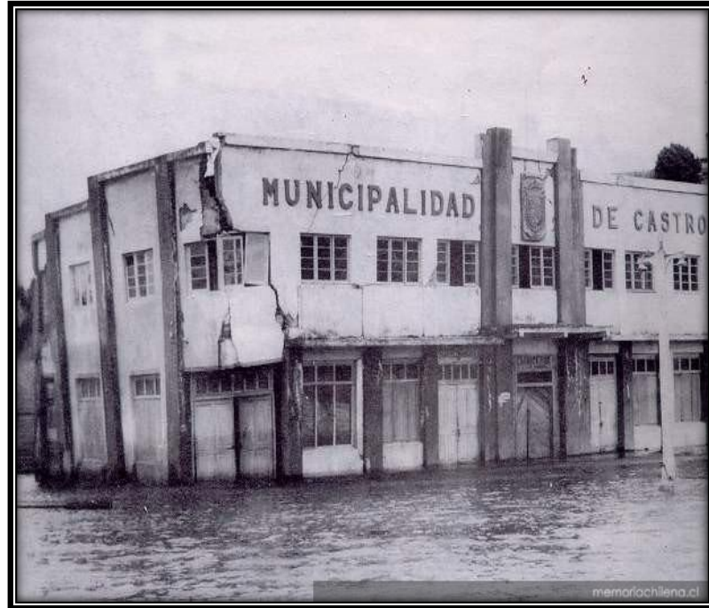
Figura 1-6 fotografía de los daños ocasionados por el terremoto de Valdivia en 1960, Chile.
