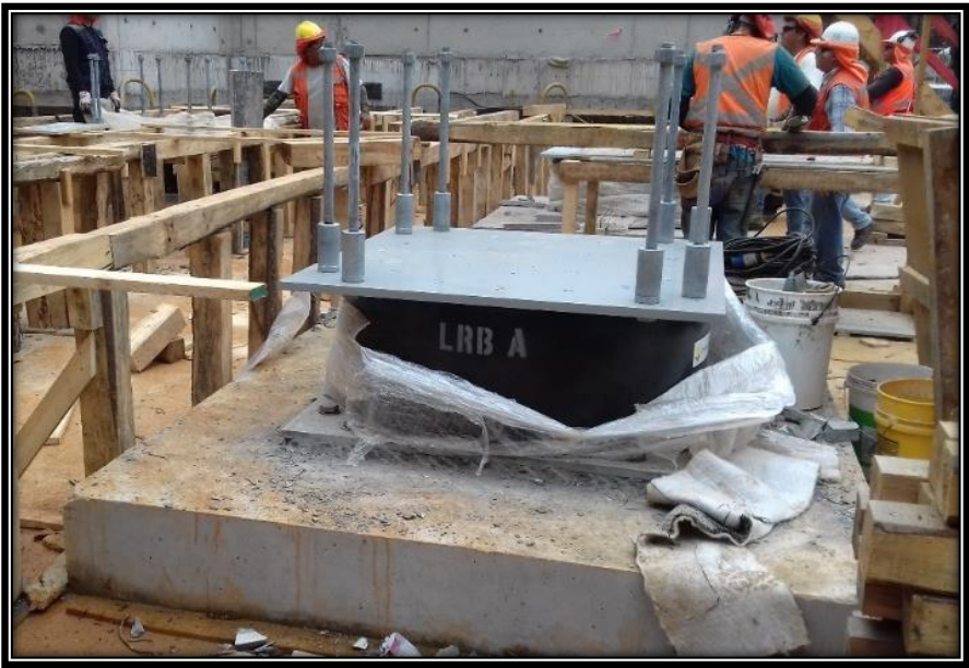
Figura 2-9 Instalación de aislador tipo A.
