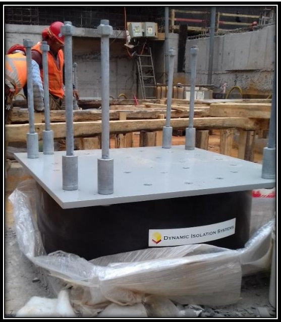
Figura 2-17 instalación de un aislador sísmico.
