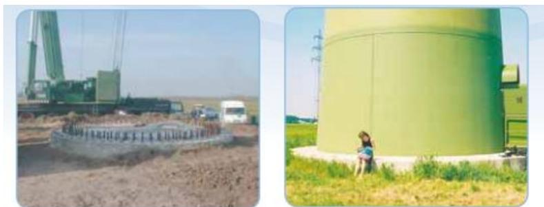
**Figura 2.30:** Soporte utilizado en aerogeneradores onshore
