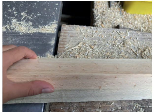
Figura 268 - 271: Primera etapa - Cepillado de los palos 2x2". Elaboración propia.
