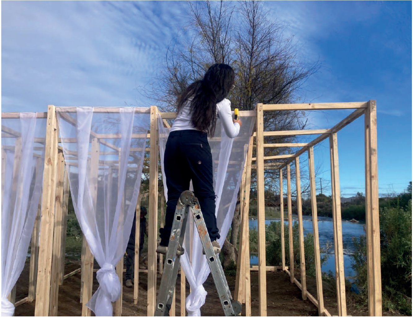
Figura 367: Montaje de la estructura del pabellón - Experiencia N°2. Elaboración propia.
