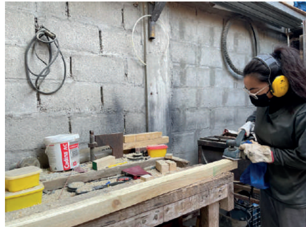
Figura 264 - 267: Primera etapa - Cepillado de los palos 2x2". Elaboración propia.
