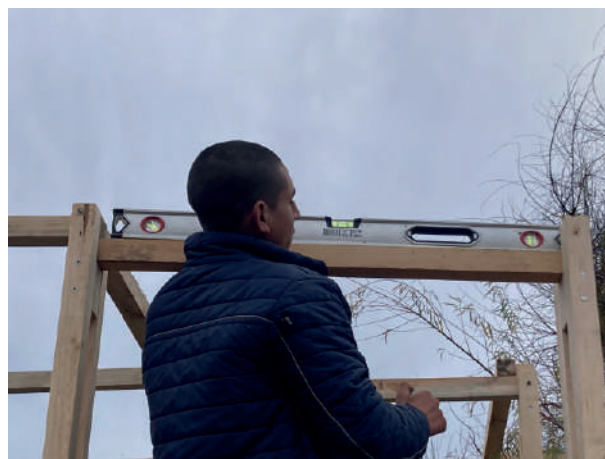
Figura 355 - 358: Montaje de la estructura del pabellón - Experiencia N°2. Elaboración propia.
