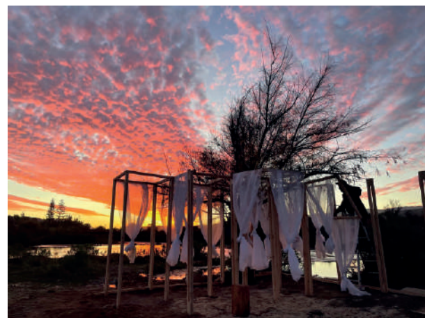
Figura 481 - 484: Desmontaje - Experiencia N°2. Elaboración propia.
