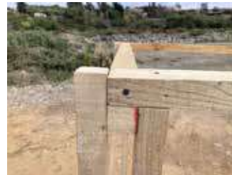
Figura 133: Tipo de unión - prototipo N°2. Elaboración propia.
