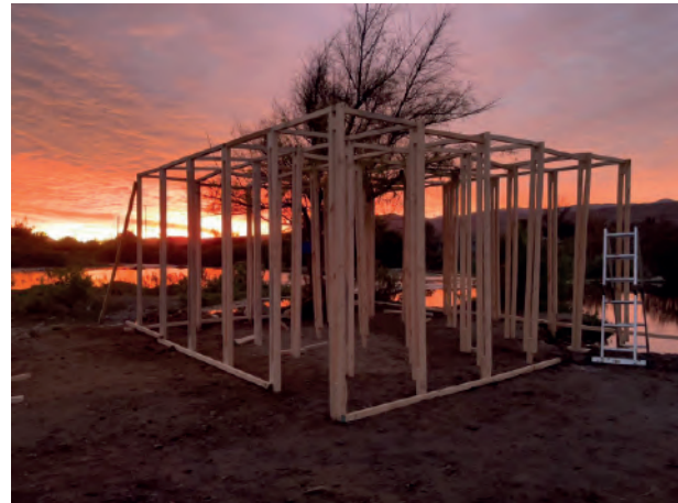
Figura 363 - 366: Montaje de la estructura del pabellón - Experiencia N°2. Elaboración propia.
