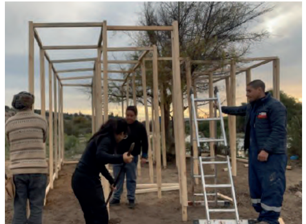
Figura 359 - 362: Montaje de la estructura del pabellón - Experiencia N°2. Elaboración propia.
