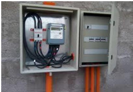
Figura 16: Empalme trifásico.
