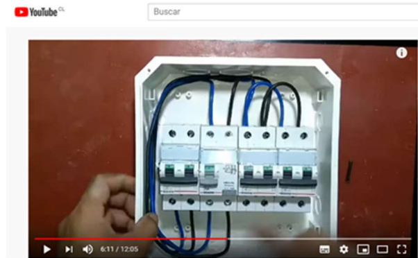
Fig.2-12. Puentes Entre Dispositivos.
