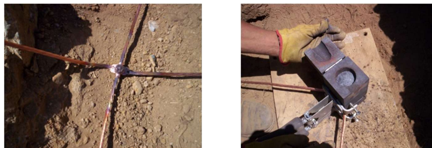
Fig. 3-13 y Fig. 3-14. Unión de Termofusión y Molde de Grafito.
