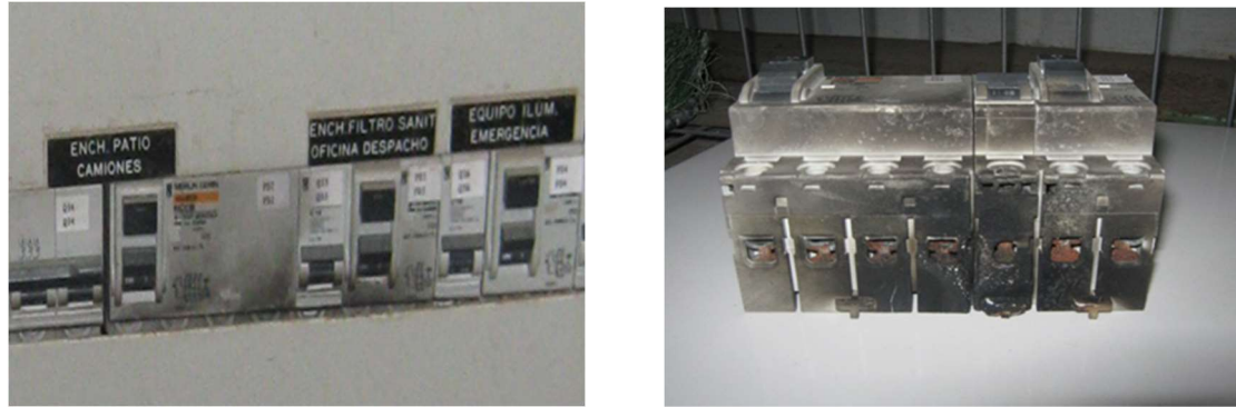
Fig.2-9 y Fig. 2-10. Protecciones Sobrecalentadas.
