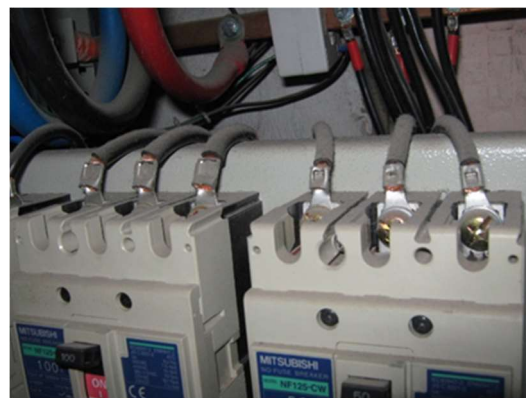
Fig.2-7 y Fig. 2-8. Puentes de Conexión.
