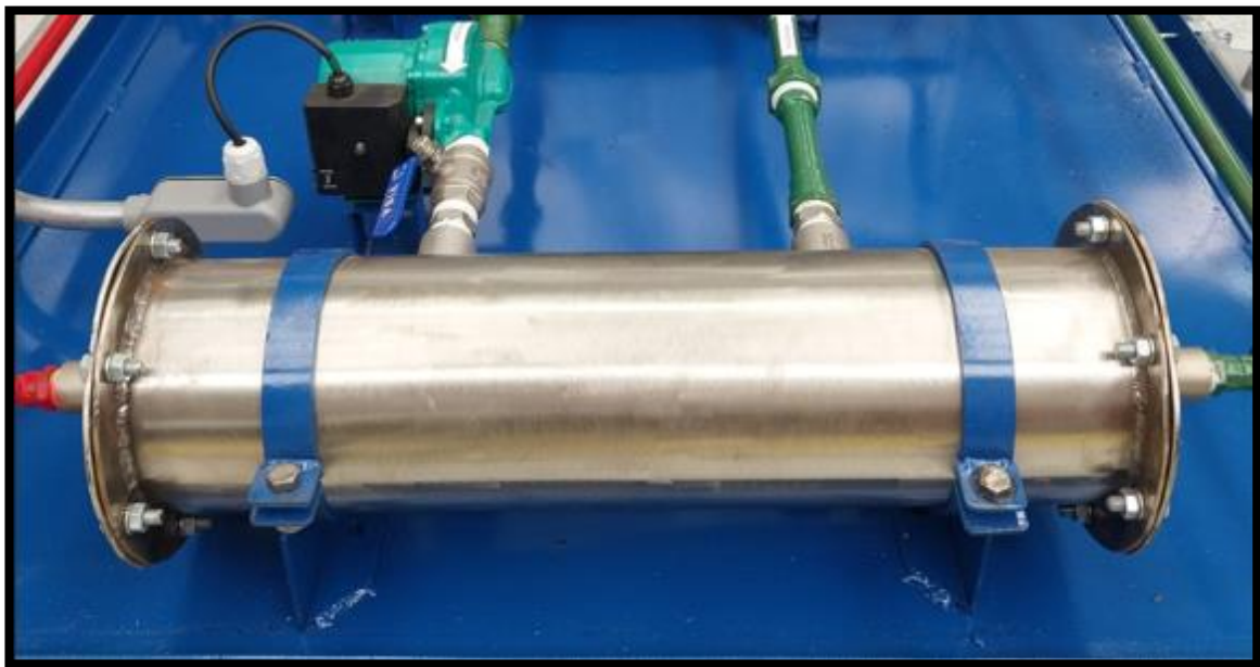
Figura 3-12. Intercambiador de calor de tubos concreticos de flujo paralelo.
