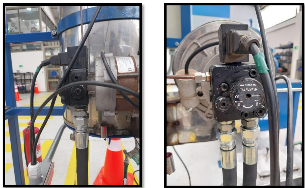
Figura 3-3. Bomba de inyección para quemador de Diesel
