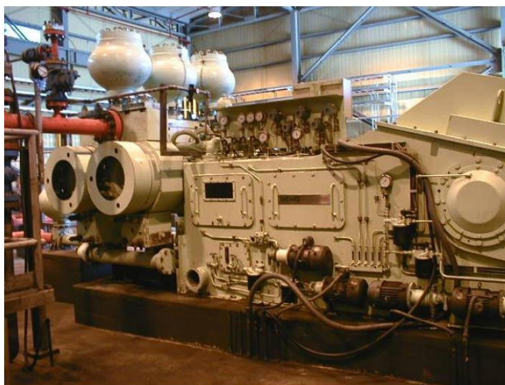
Ilustración 13. Bomba GEHO 220PP151
