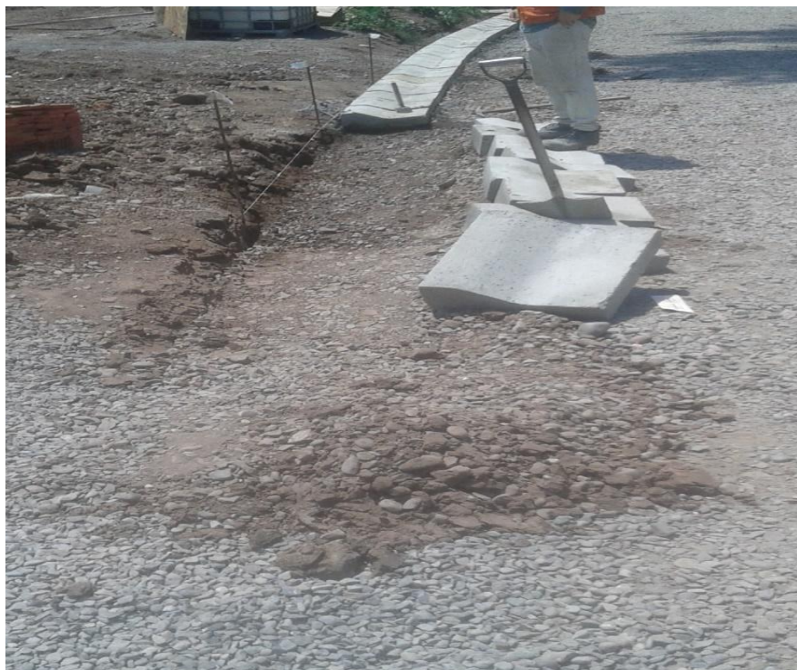
Figura 2-1 Presentación de niveles e instalación de solera.
