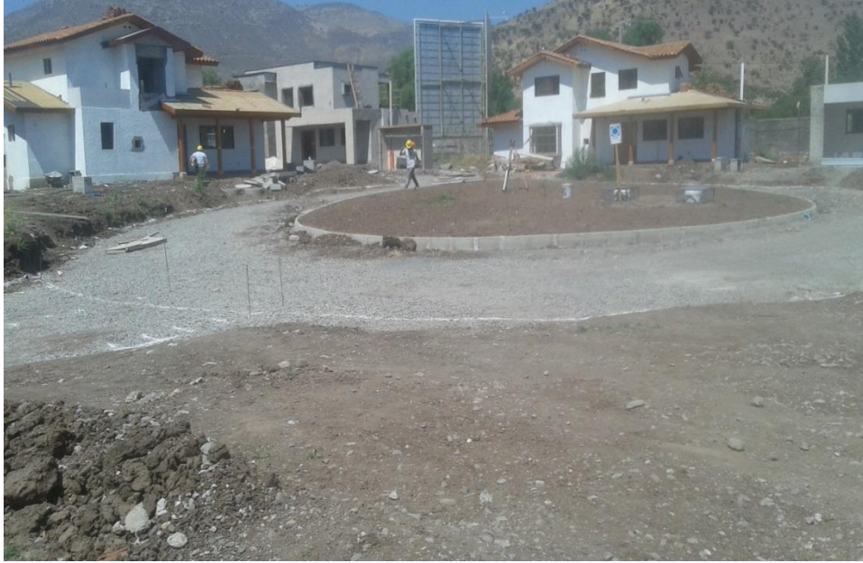
Figura 2-3 otorgando niveles a la rotonda
