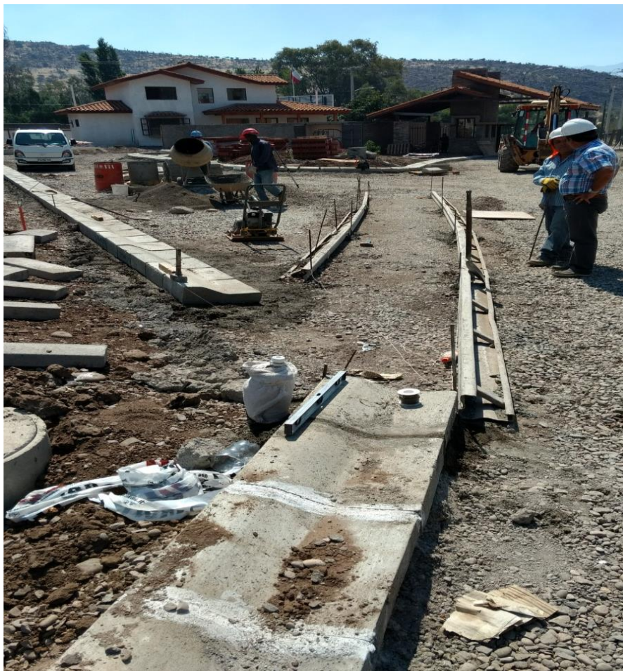
Figura 2- 15 postura de moldaje
