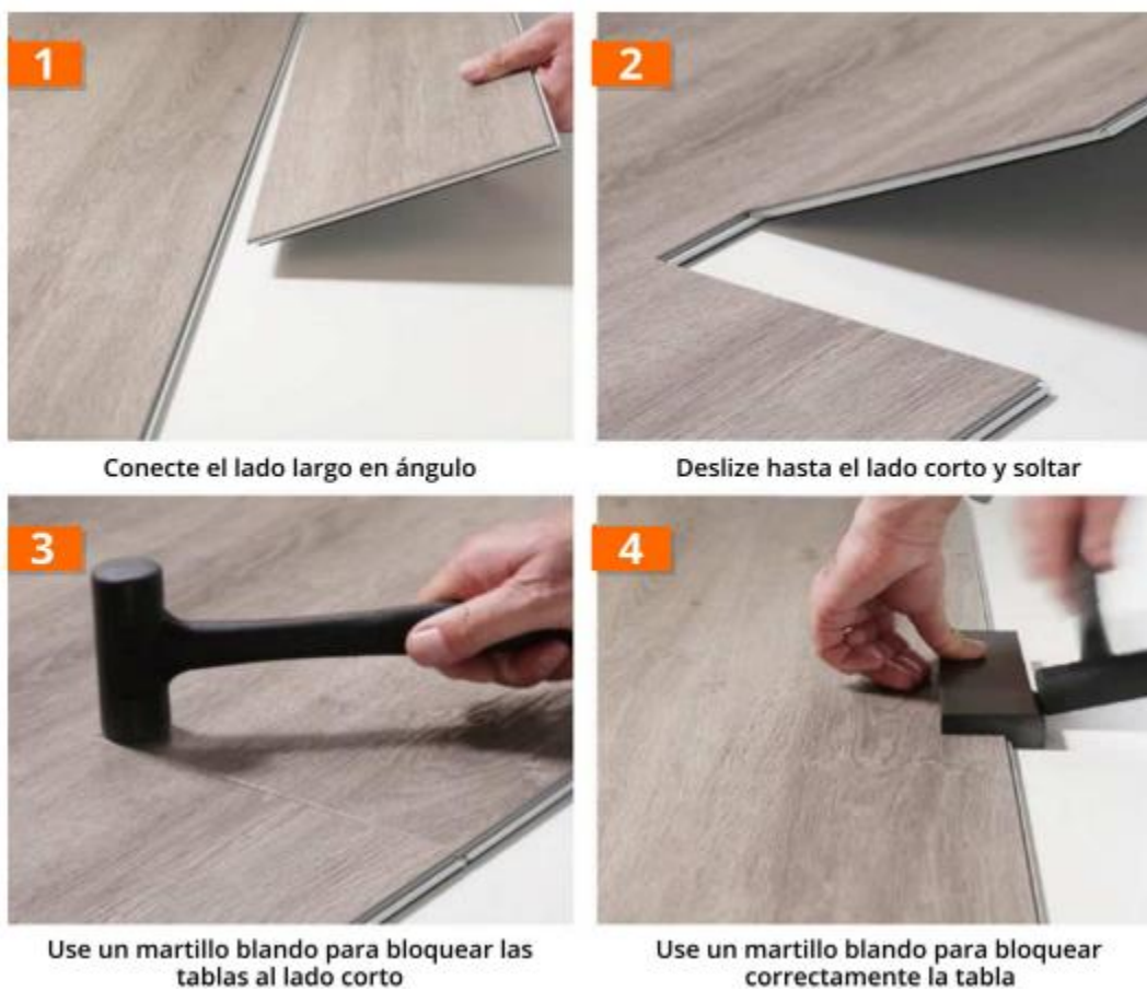
Imagen 40: instalación revestimiento de piso
