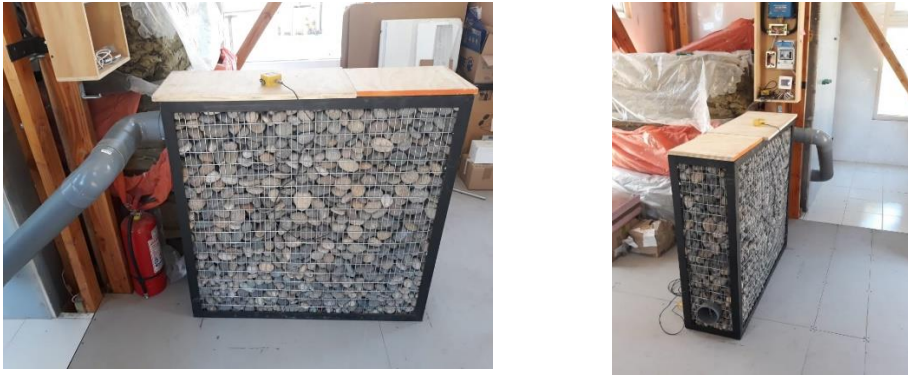
Figura 7 Muro de acumulación de grava construido e instalado en casa Fénix II.
