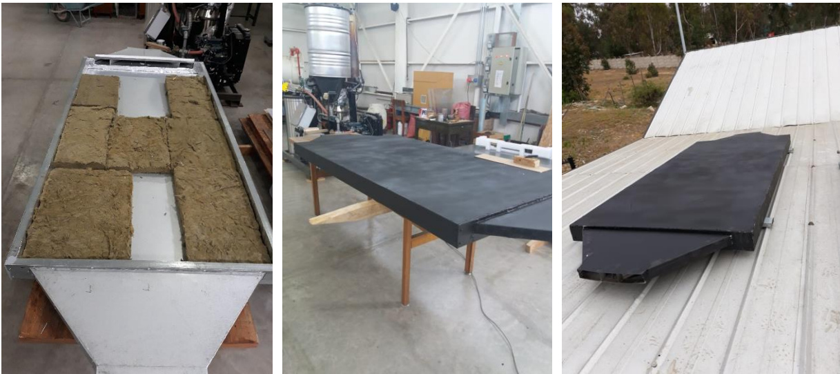
Figura 6 etapa de construcción de radiador nocturno aire radiación en LER.
