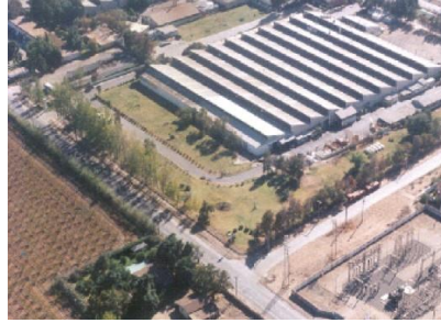
Figura 5.6: Vista Área Cormecanica. Fuente 3
